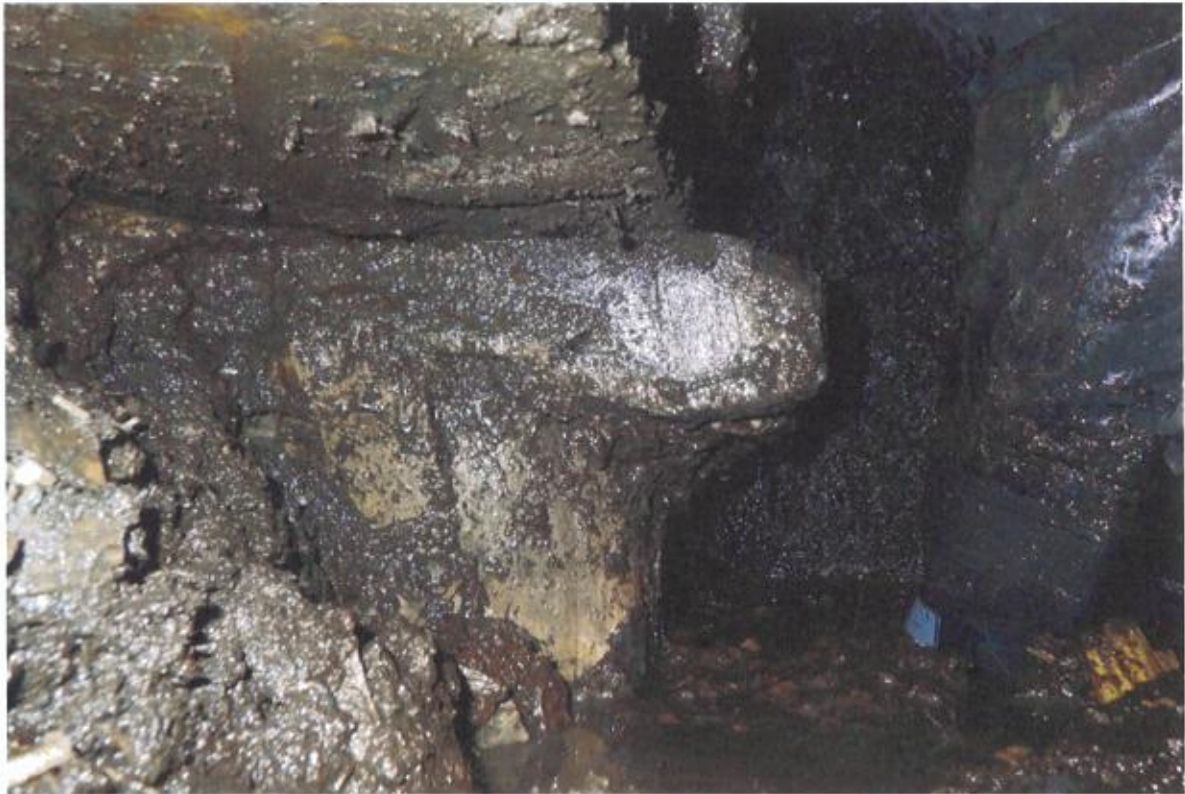
langshout 1, kesp 2 en paal 2 (kesp 2 is 50% samengedrukt)
