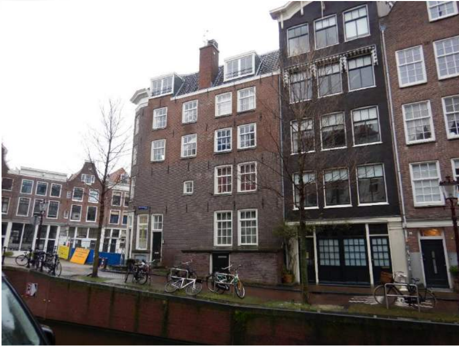
Foto 1, voorgevel 5.1, 2, e 5.1, 2, e 5.1, 2, e
