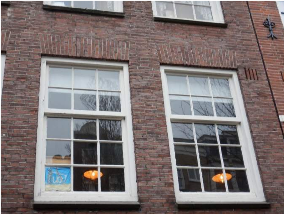
Foto 7, voorgevel 5.1, 2, e 5.1, 2, e
