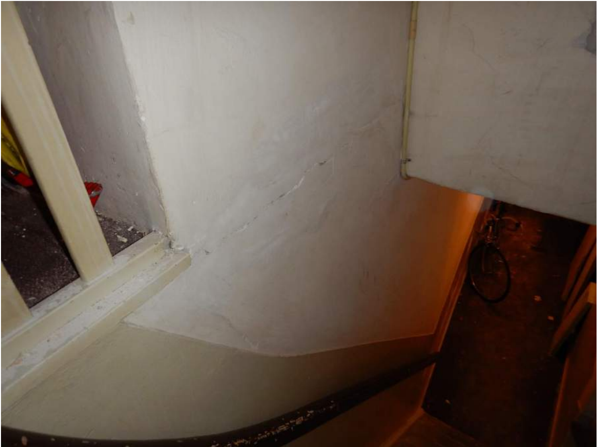
Foto 20, trappenhuis 5.1, 2, e 5.1, 2, e
