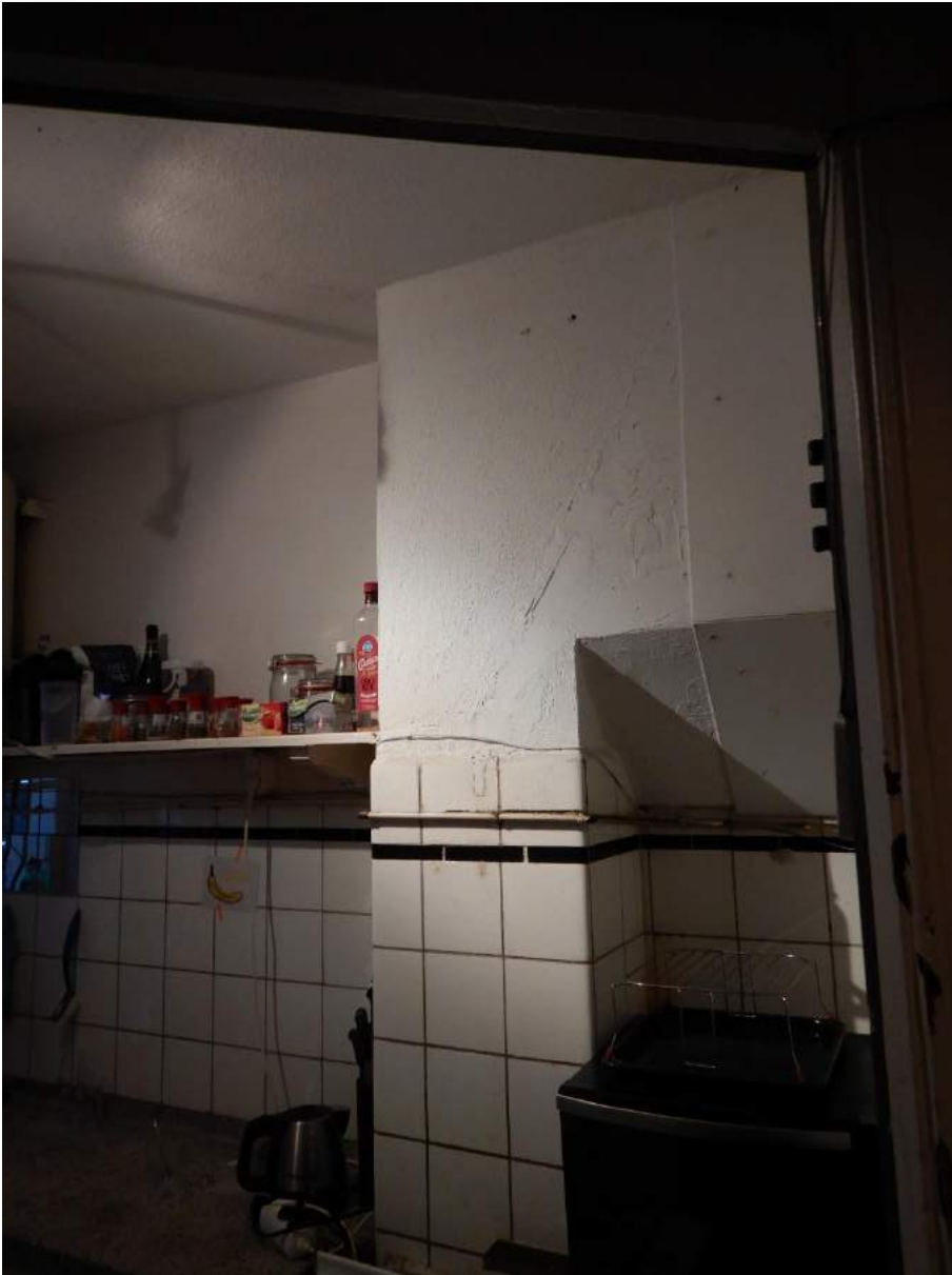
Foto 18, interieur 5.1.2, e 5.1, 2, e 1 e verdieping
