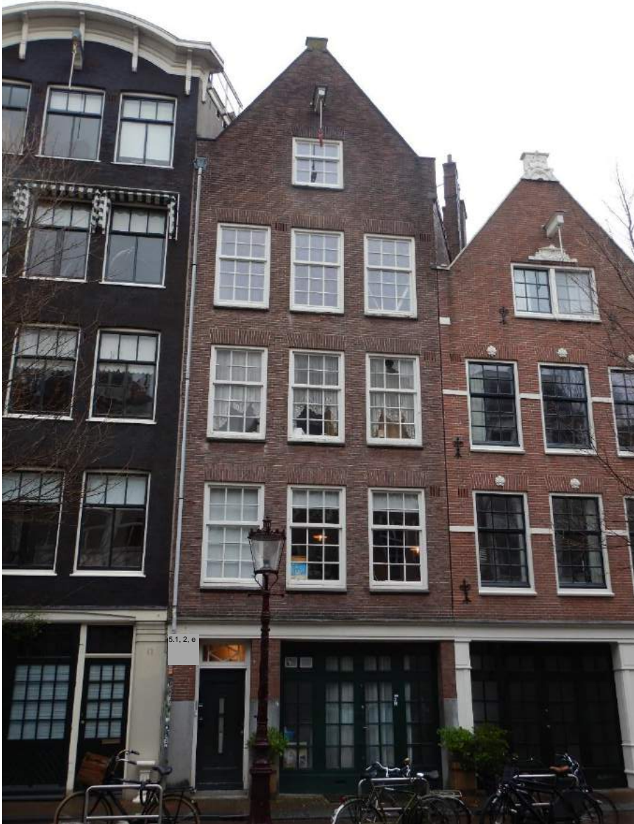
Foto 3, voorgevel 5.1, 2, e, 1, 2, e
