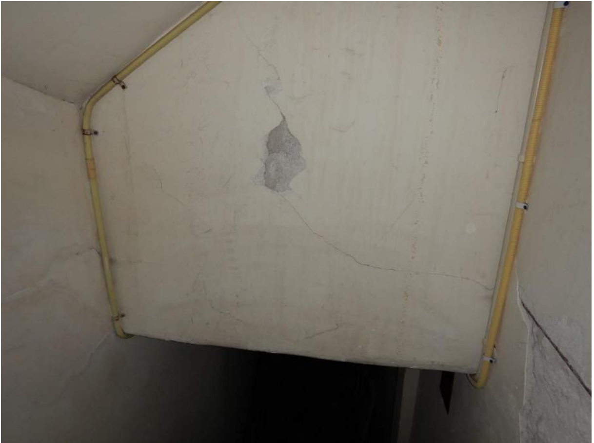
Foto 21, trappenhuis 5.1, 2, e 5.1, 2, e
