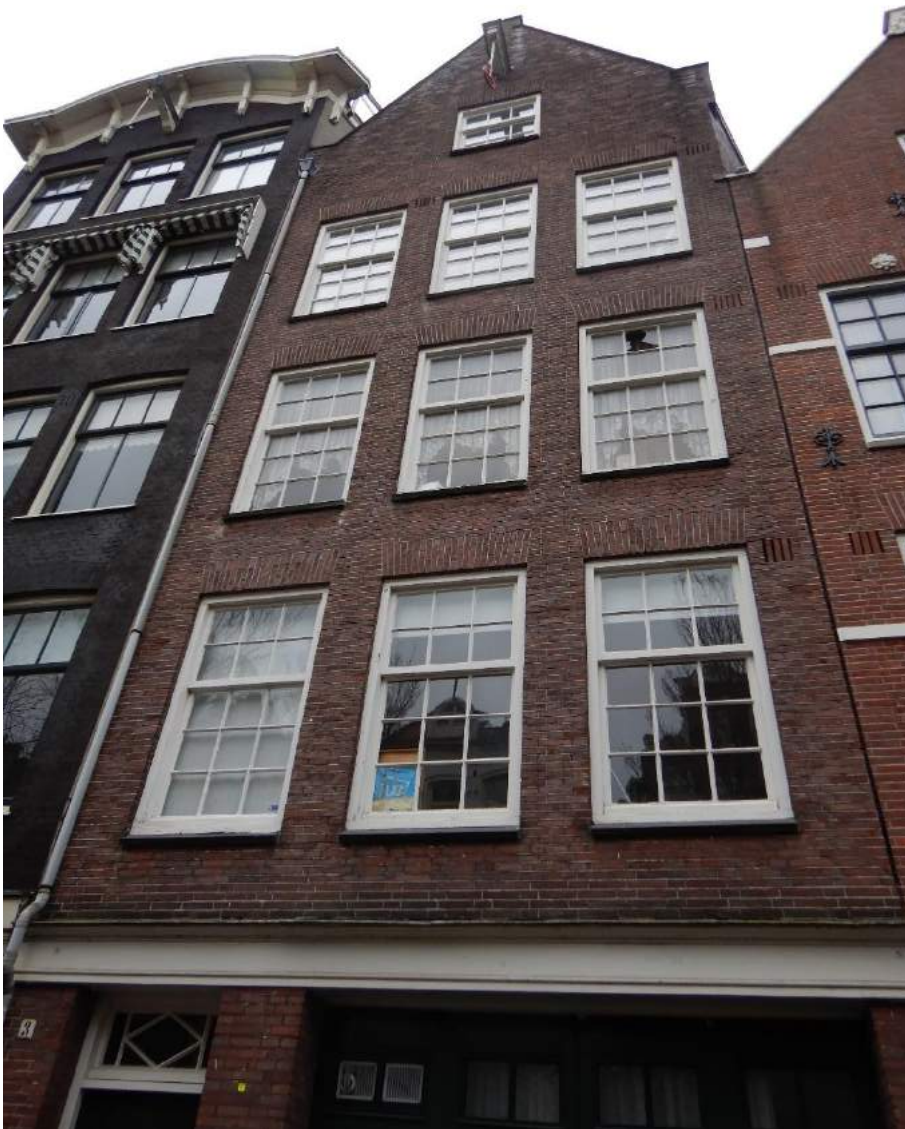
Foto 5, voorgevel 5.1, 2, e, 1, 2, e
