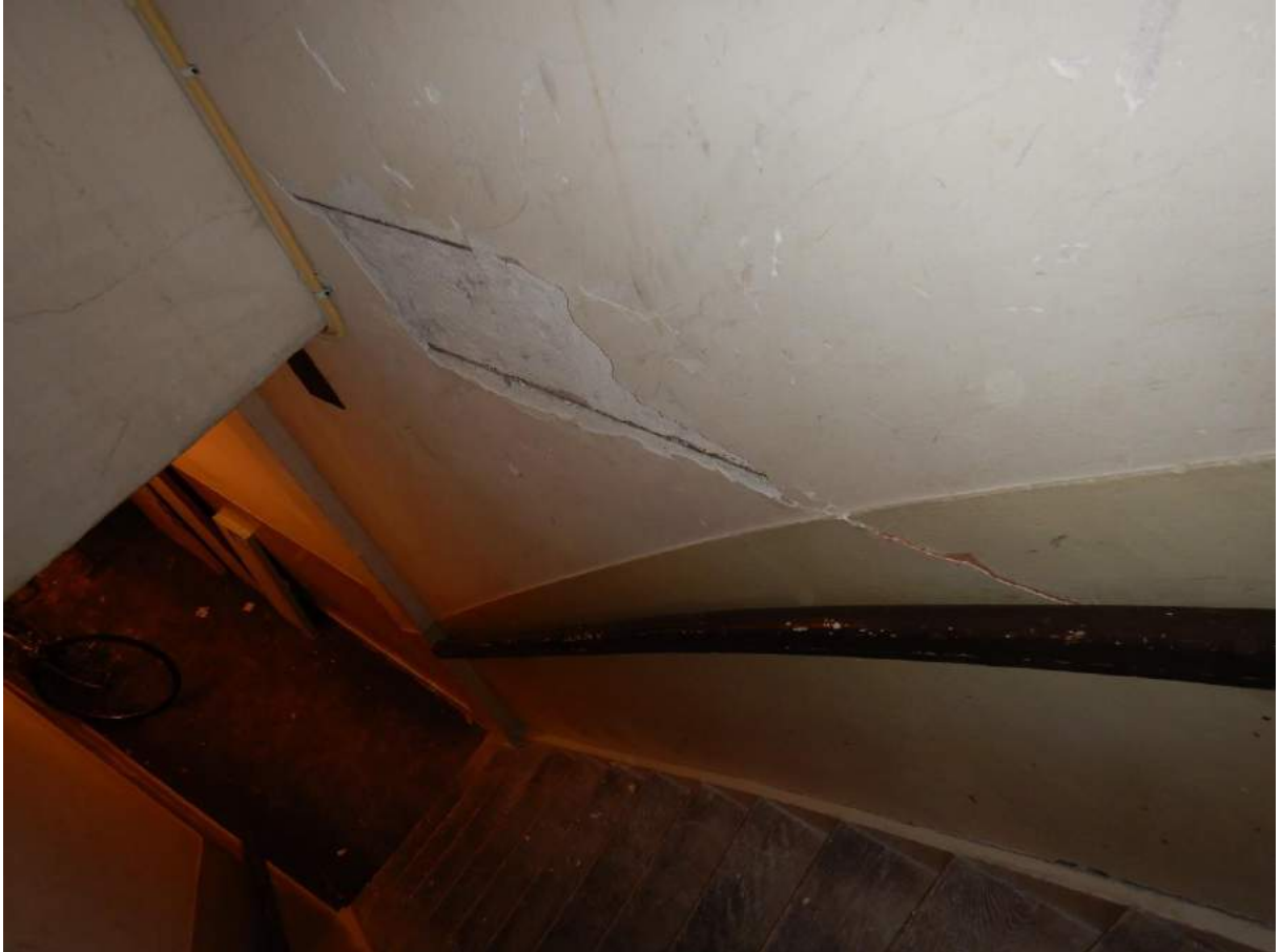
Foto 19, trappenhuis 5.1, 2, e 5.1, 2, e
