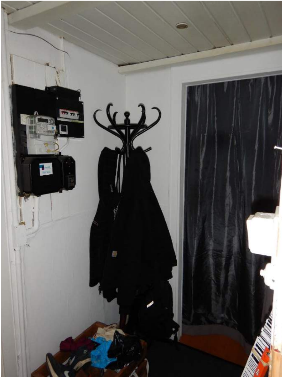
Foto 22, interieur 5.1, 2, e 5.1, 2, e 1 e verdieping
