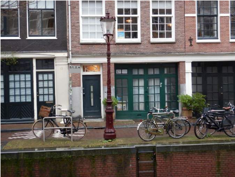
Foto 4, voorgevel 5.1.2, e 5.1.2, e
