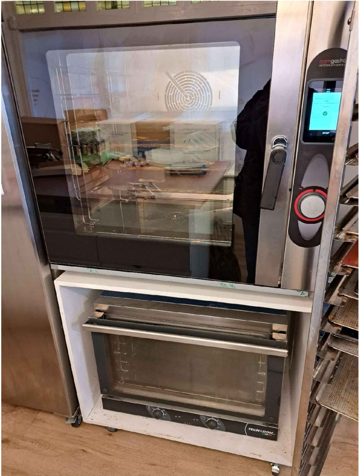
Foto gemaakt op 27-3-2025. Ovens in de opslag.
