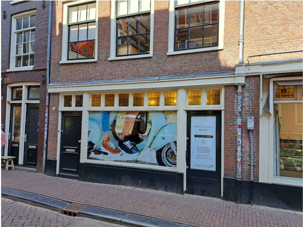
Foto gemaakt op 27-3-2025. Van de zijgevel aan de Oude Spiegelstraat zijn de ramen dichtgezet.
