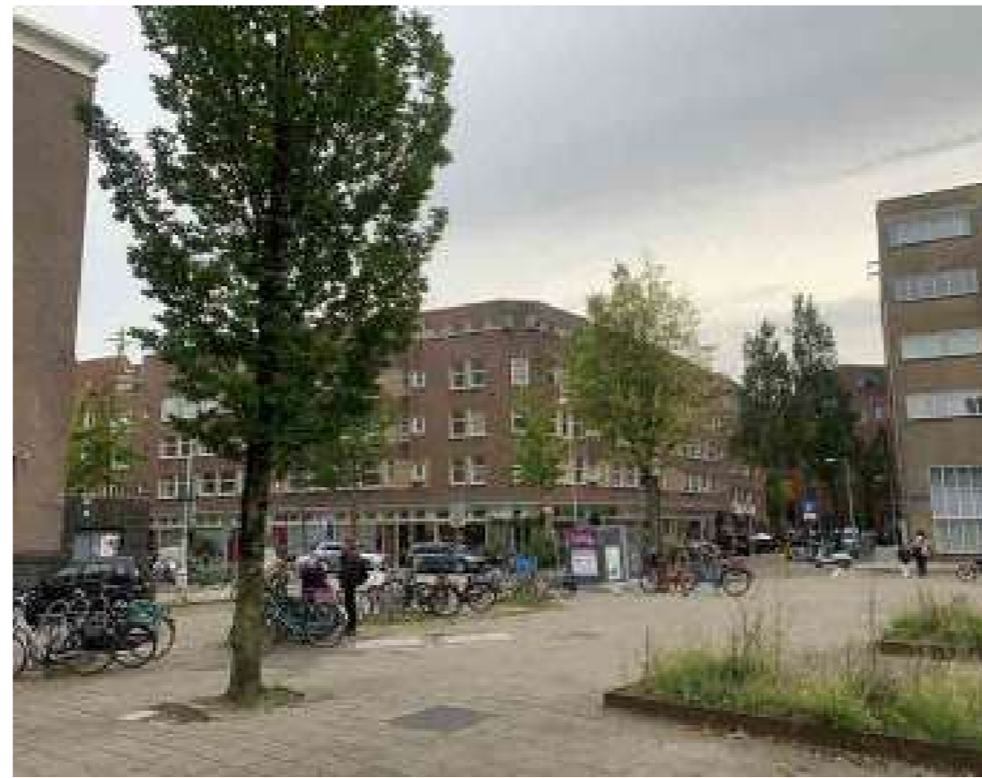
Mauritskade | Bouwblok A
