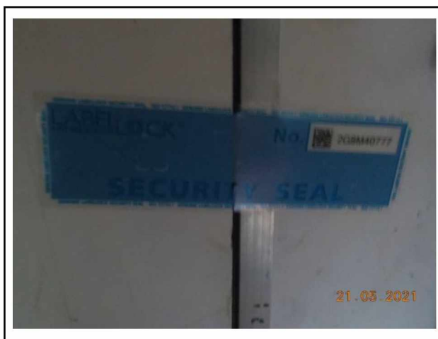
Foto 6: Het containment is verzegeld tijdens de luchtmeting.
