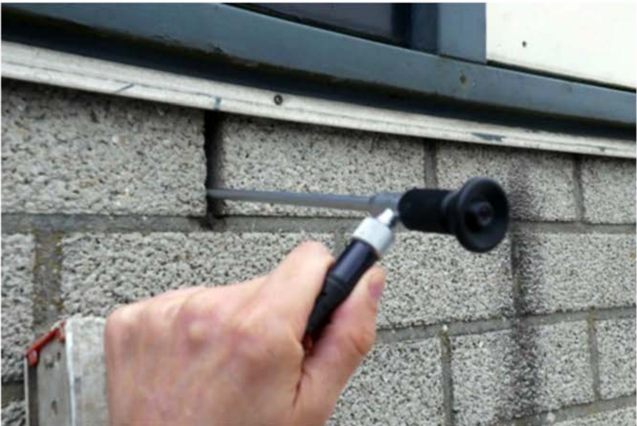
Afb.1: endoscoop in een van de gecontroleerde spouwvoegen van het object aan de 5.1.2.e te amsterdam.
