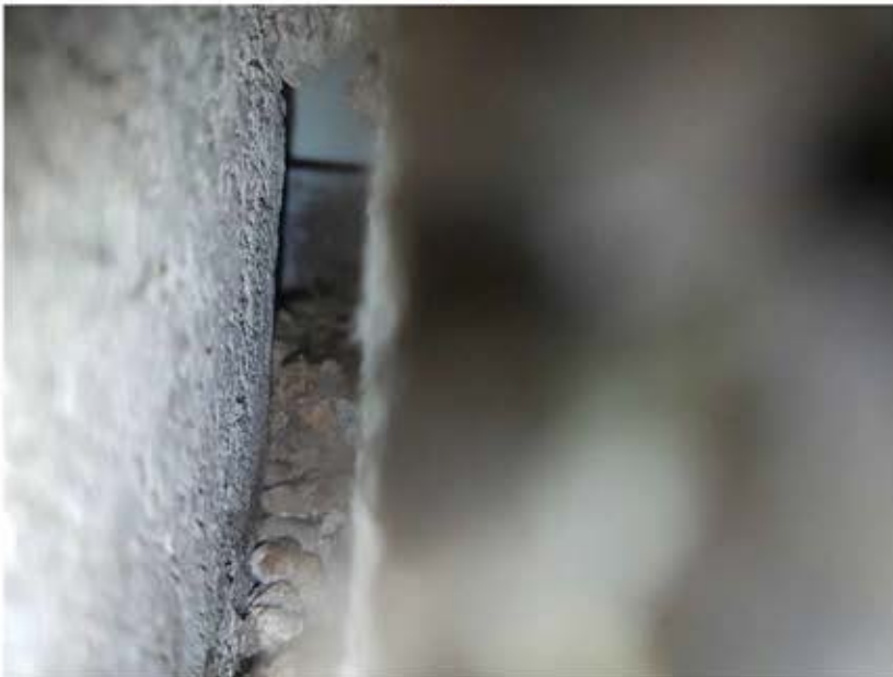
Open stootvoegen maken spouw toegankelijk voor gewone dwergvleermuis.
