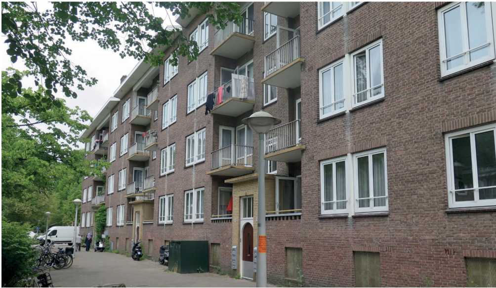
Bestaande situatie gevel anno 2021
