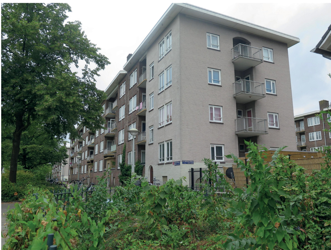
Huidige status van de kopgevels aan het Lidewijdepad
