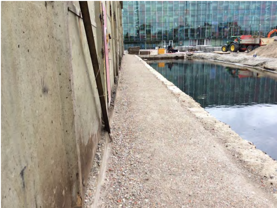
Strook tussen betonnen bak en hal
