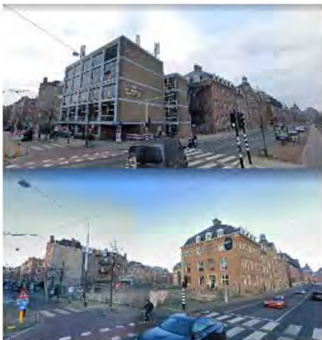
Figuur 2.3 Plangebied vanaf de Albert Cuypbrug voor de sloop van bouwdelen A en C (boven) en na de sloop (onder).
