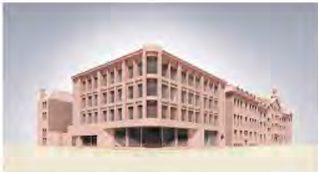
Figuur 2.8 Nieuwe aula gevelaanzicht
