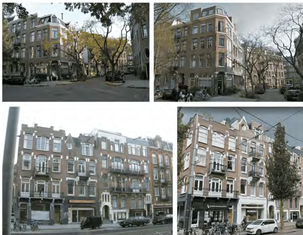
Abbeelding: Hondecoetersstraat5 (boven) en Van Baerlestraat 55 (onder): voorbeelden van het toevoegen van een extra bouwlaag onder de kap
