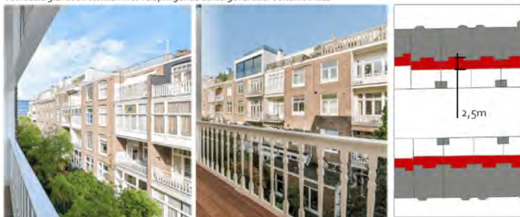
Voorbeeld 5.1: bouwblokken met verspringende achtergevel door buitenruimtes
