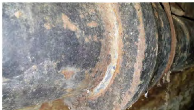
F09 Andreas Bonnstraat 15H De gietijzer verbinding van de riolering is afgedicht met lood
