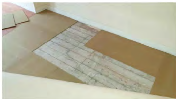
F05 Andreas Bonnstraat 15-1 Geen asbestverdachte toepassingen op de houten vloer
