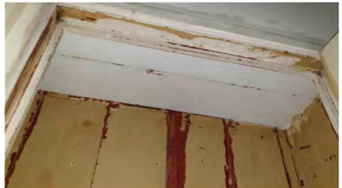
F14 Andreas Bonnstraat 9H In de kasten is een houten plafond toegepast
