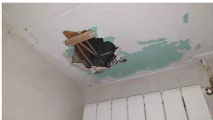
F09 Andreas Bonnstraat 7H Geen asbestverdachte toepassingen boven verlaagd plafond
