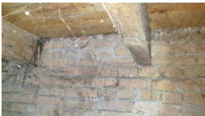
F10 Andreas Bonnstraat 15H Onder de balken zijn geen asbestverdachte stelplaatjes toegepast
