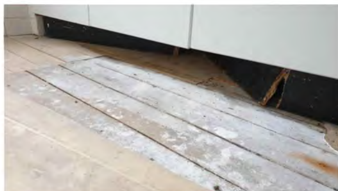
F01 Andreas Bonnstraat 15-1 Geen asbestverdachte toepassingen onder het keukenblok
