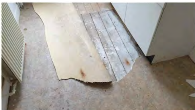
F04 Andreas Bonnstraat 15-1 Geen asbestverdachte toepassingen op de houten vloer
