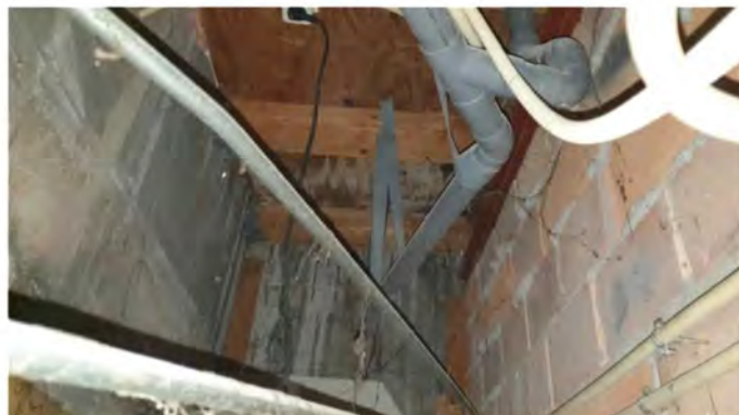
F02 Andreas Bonnstraat 17H Geen asbestverdachte toepassingen boven het verlaagde plafond
