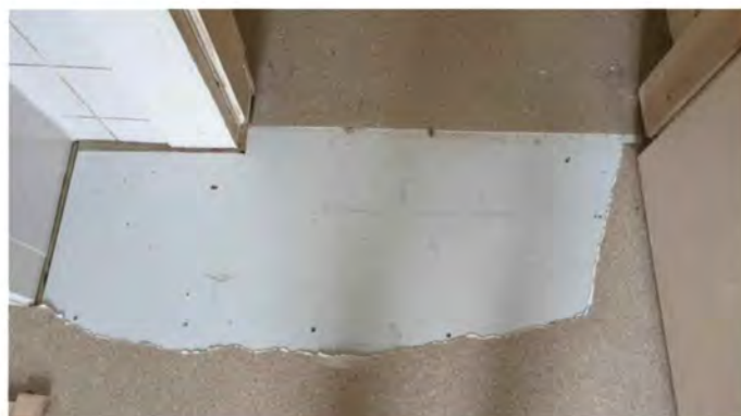
F1 Andreas Bonnstraat 15-3 Niet asbestverdachte Fermacell vloerplaten
