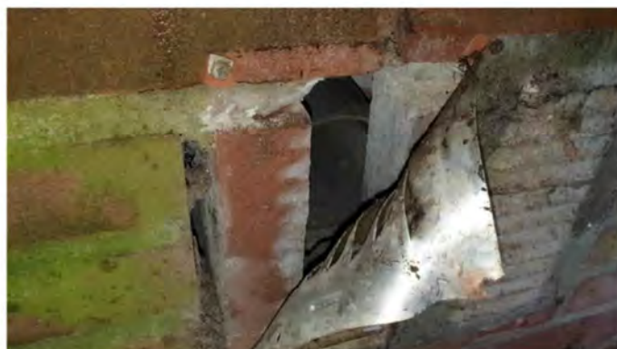
F14 Andreas Bonnstraat 17H Geen asbestverdachte toepassingen bij de gevelventilatie
