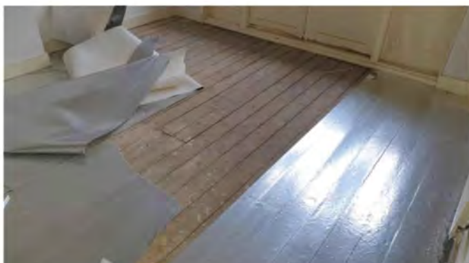
F02 Andreas Bonnstraat 15-1 Geen asbestverdachte toepassingen op de houten vloer
