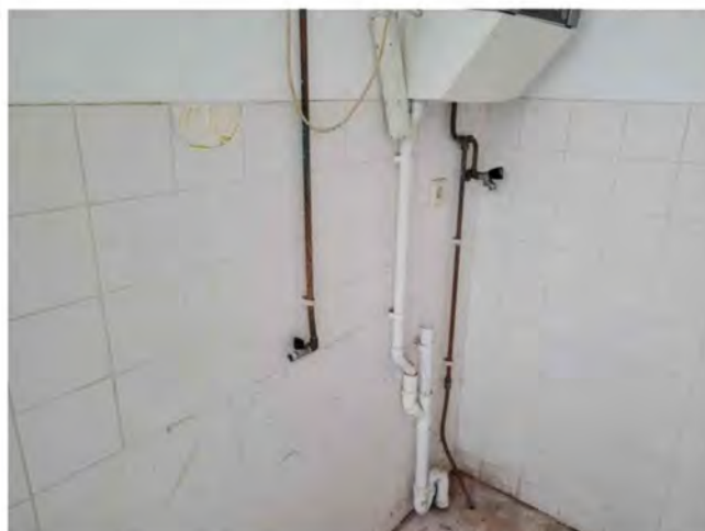
F06 Andreas Bonnstraat 11H Recent aangebracht tegelwerk
