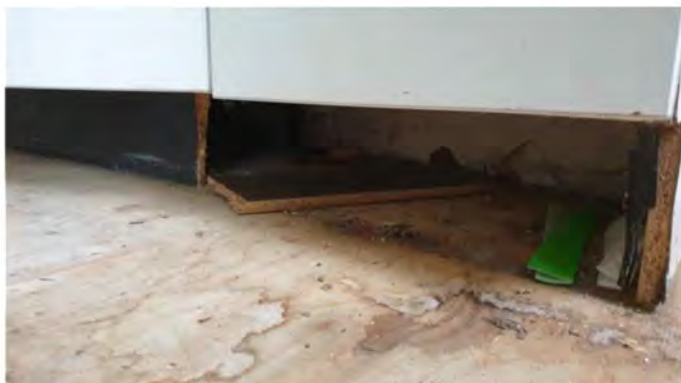
F01 Andreas Bonnstraat 17H Geen asbestverdachte toepassingen onder het keukenblok
