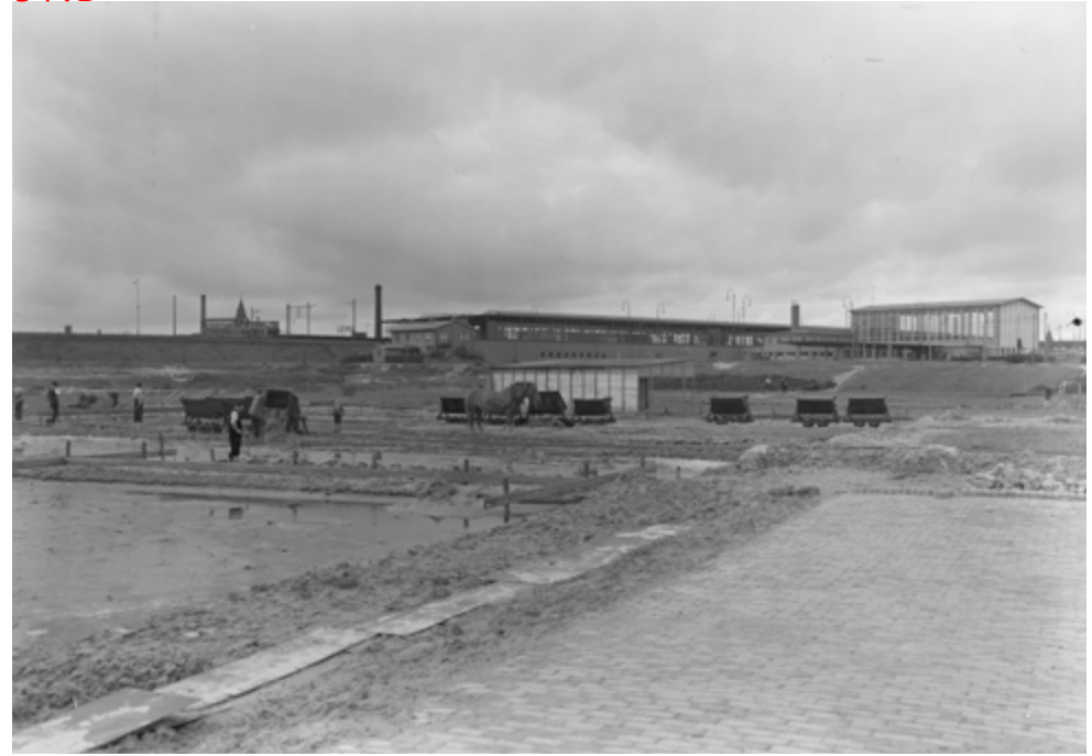
1946 najaar, bouwvoorbereiding met Amstelstation op de achtergrond. [SAA]
