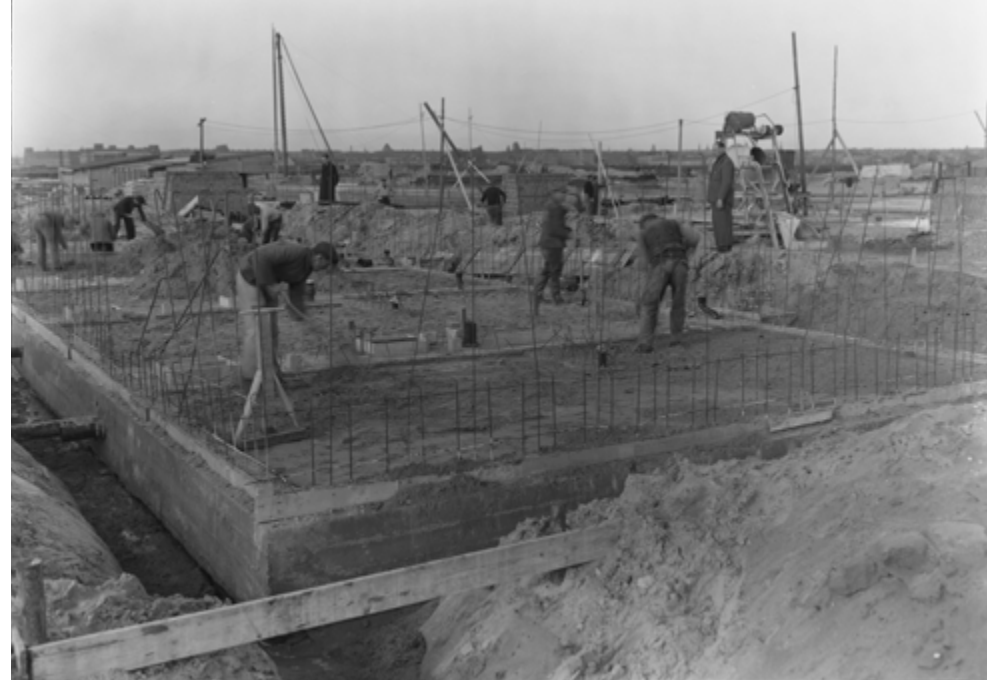
1946 oktober, fundering van gewapend beton.
