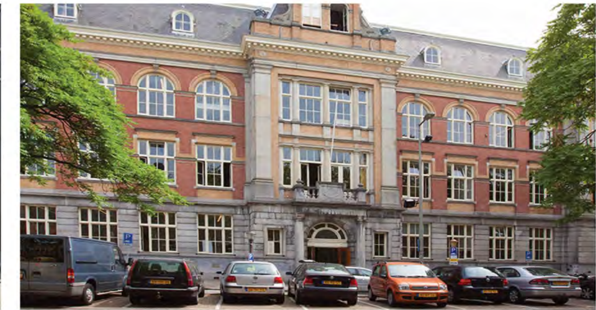
gevel HES gebouw
