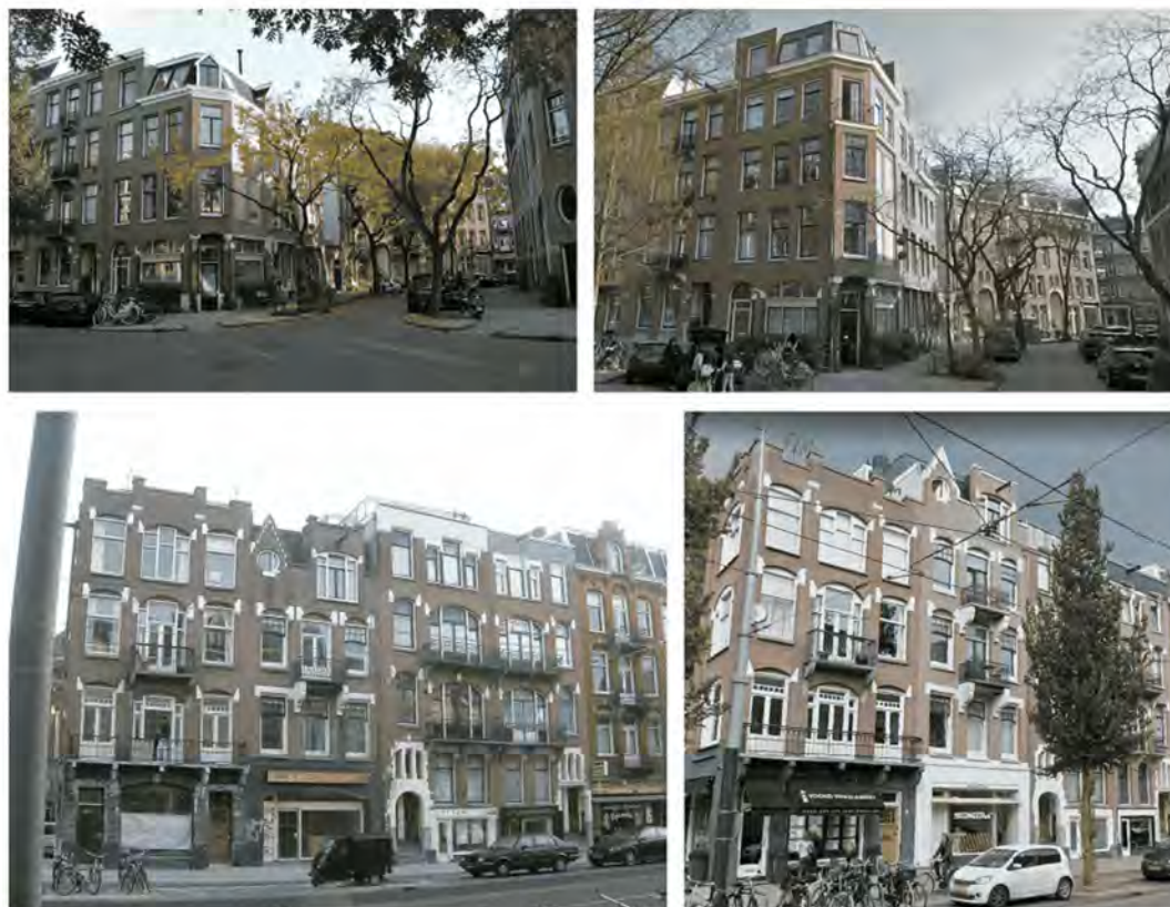
Afbeelding: Hondecoetersstraat 5 (boven) en Van Baerlestraat 55 (onder): voorbeelden van het toevoegen van een extra bouwlaag onder de kap
