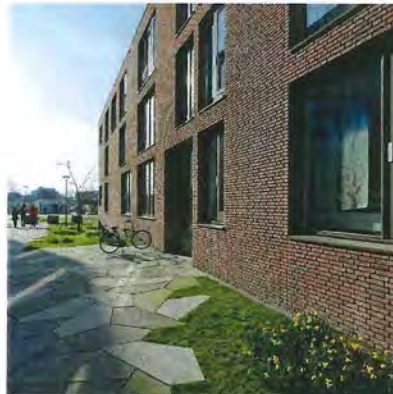
Baksteen en maaiveldaanluiting: Funenpark, Amsterdam
