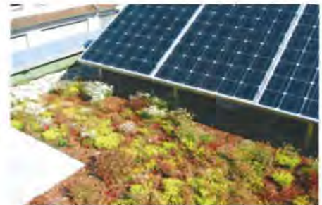
PV in combinatie met een sedumdak: waterretentie en energieopwekking
