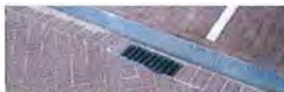
Afwatering Straatkolk 20x45 in rollaag of trottoirkolk van 30 cm diep in trottoirband van 30 cm
