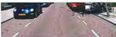
Rijweg Rode gebakken klinker, keiformaat keperverband (30 km/u straat) of asfalt (50/u km), tonrond
