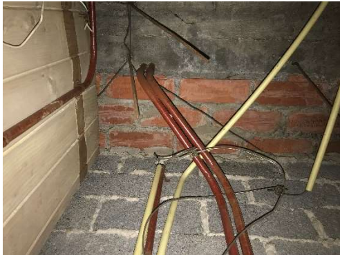
Figuur 2.14: Perfora verdiepingsvloer
