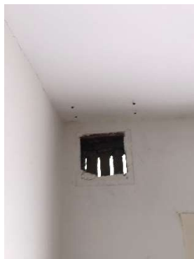
Figuren 2.16, 2.17 en 2.18: Rooster vanaf binnenzijde, binnenzijde zonder rooster, stootvoeg buitenzijde.
