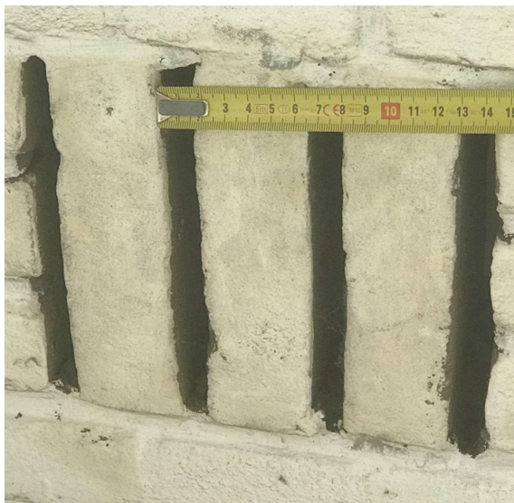
Figuur 5.1: Afmetingen stootvoeg
