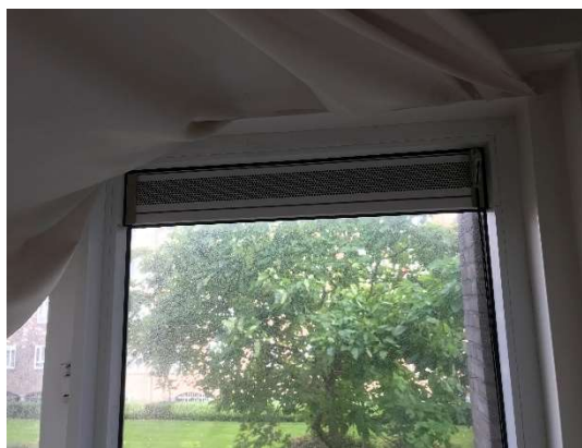
Figuur 2.19 en 2.20: Ventilatioeroosters binnen en buitenzijde.
