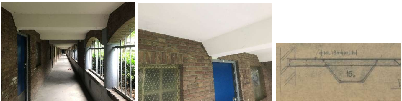
Figuren 2.11, 2.12 en 2.13: Vloer die tussen de bergingen en de woningen
