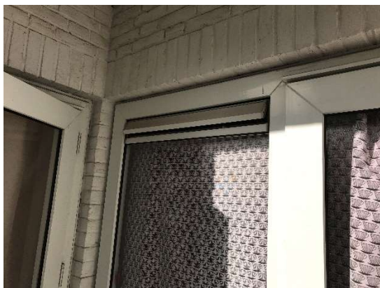
Figuur 2.19 en 2.20: Ventilatioeroosters binnen en buitenzijde.
