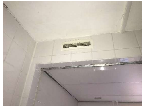
Figuur 2.15: Het stucplafond en systeemplafond
