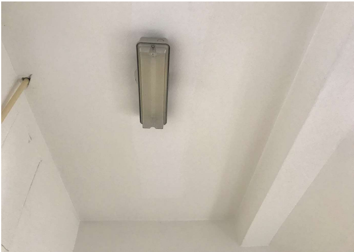
Figuur 11.1: Huidige situatie onderzijde bordes (zonder absorptie) in het trappenhuis.
