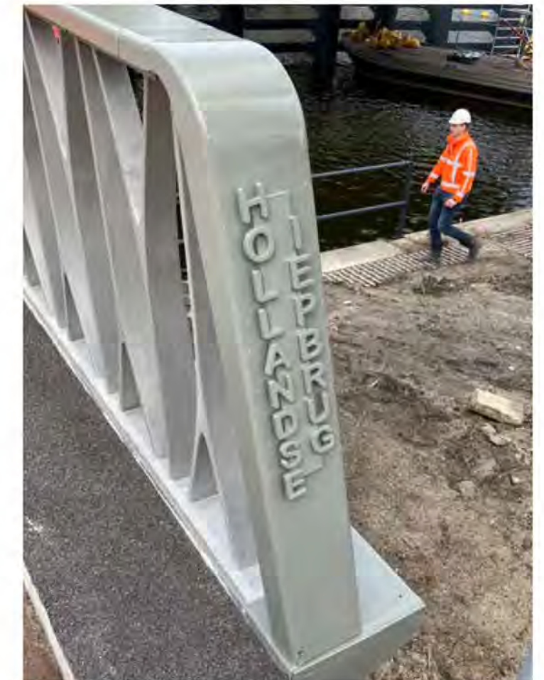
referentie brugnaam en plaat
