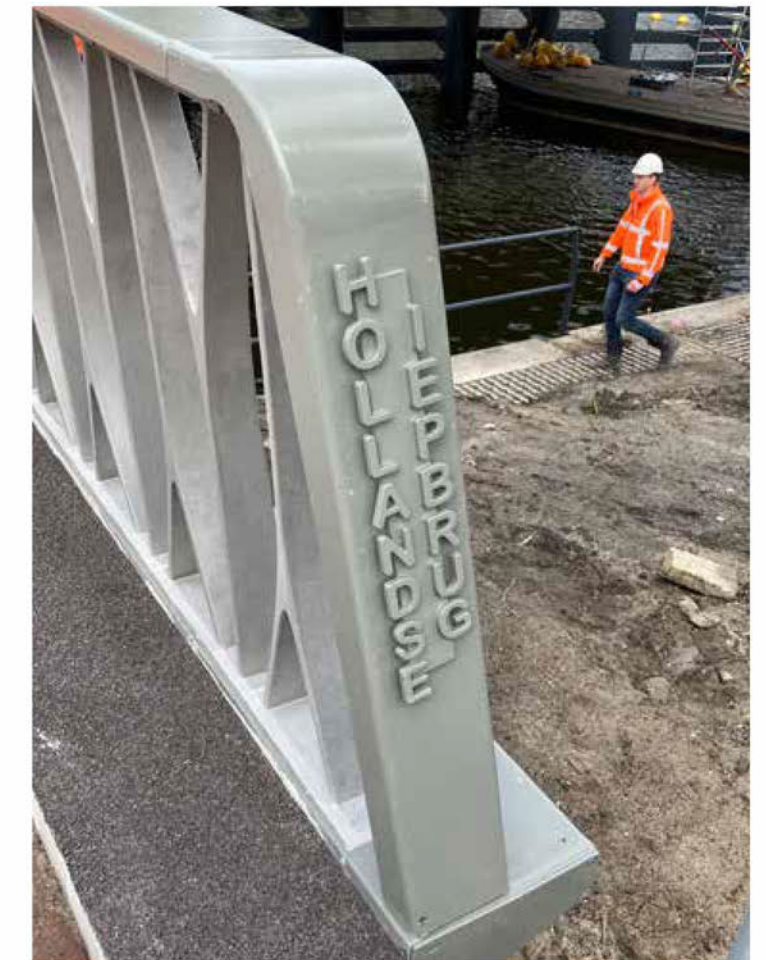
referentie brugnaam en plaat
