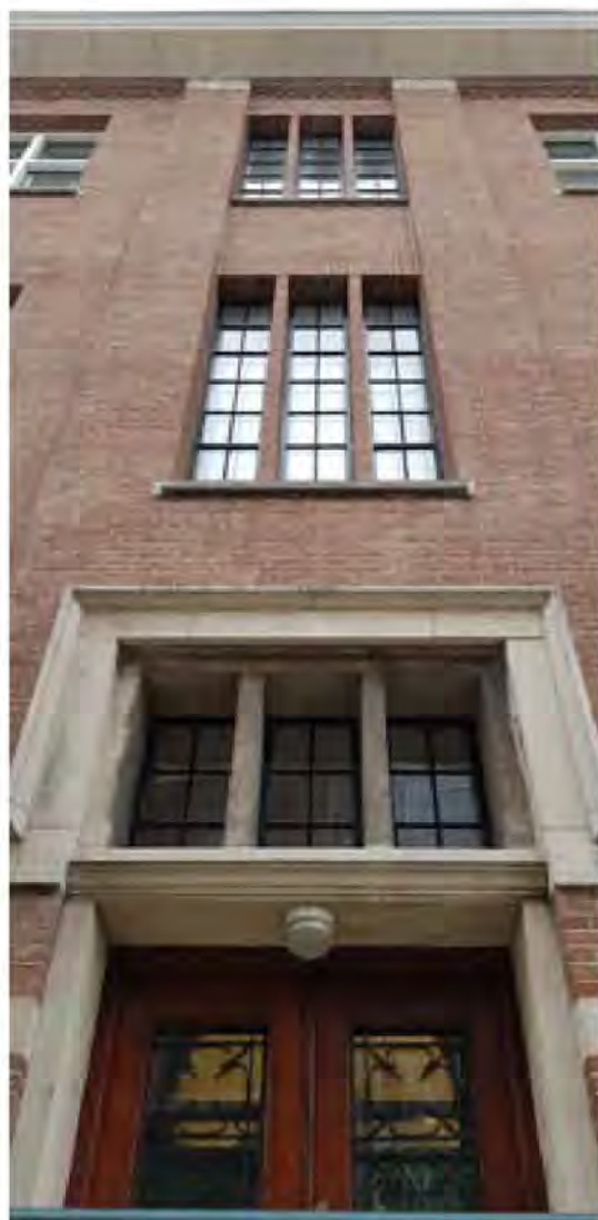
foto van de huidige kopgevel van gebouw D
