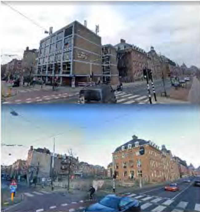
Figuur 2.3 Plangebied vanaf de Albert Cuypbrug voor de sloop van bouwdelen A en C (boven) en na de sloop (onder).
