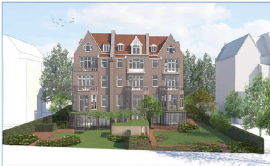
Achteraanzicht Van Eeghenstraat 94 – 98 te Amsterdam (bron: Kodde Architecten)
