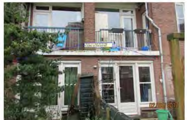
Figuur 5: foto van bouwblok met voorstel inzaging met diepte 50 mm
