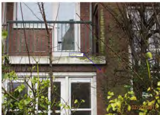
Figuur 5: foto van bouwblok met voorstel inzaging met diepte 50 mm
