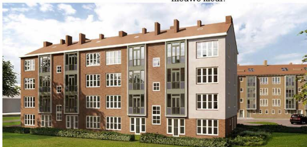
Impressie van een bouwblok na renovatie
