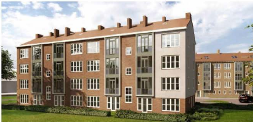
Impressie van een bouwblok na renovatie
