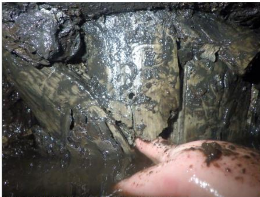
Afbeelding 7: Bellamystraat 36/38, paal 1 is hol van binnen
