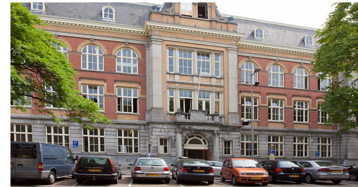
gevel HES gebouw
