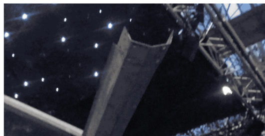
Figuur 3-2: Dragende dakgoot. Bron: Kasverhuur.nl
