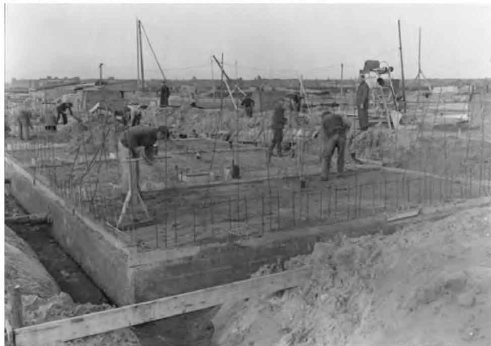
1946 oktober, fundering van gewapend beton.
