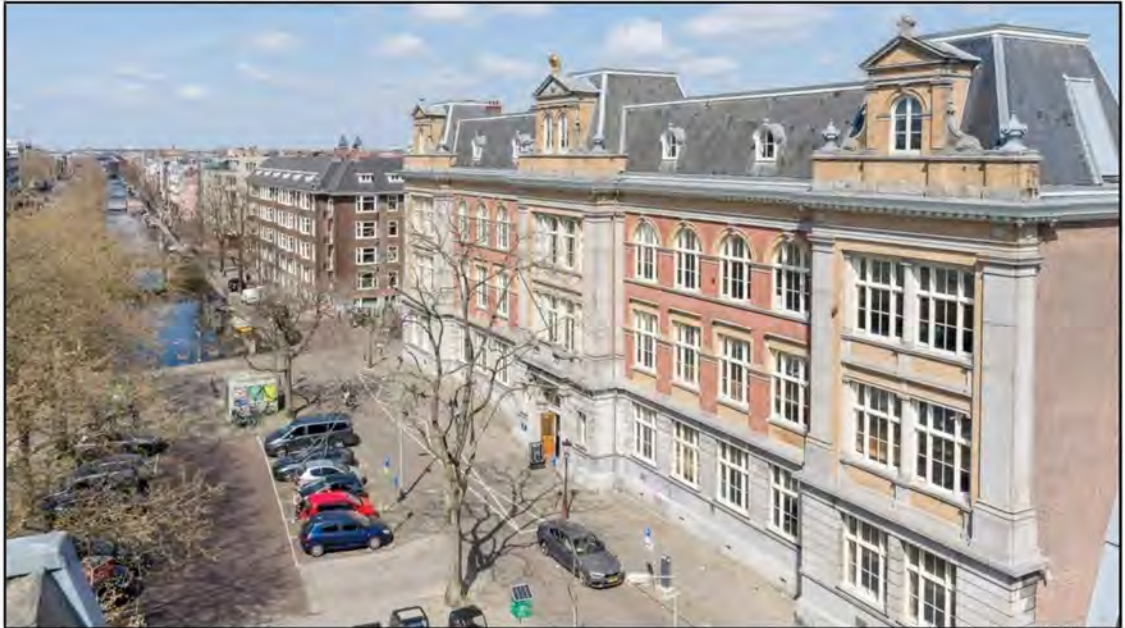
Figuur 47. Het voormalige schoolgebouw aan Raamplein 1
