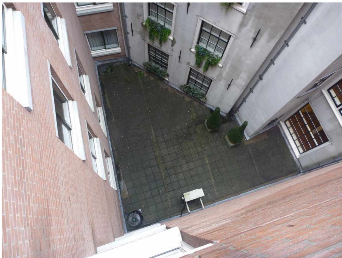
Lichthof 1, dakvloer ligt op niveau 1e verdieping
