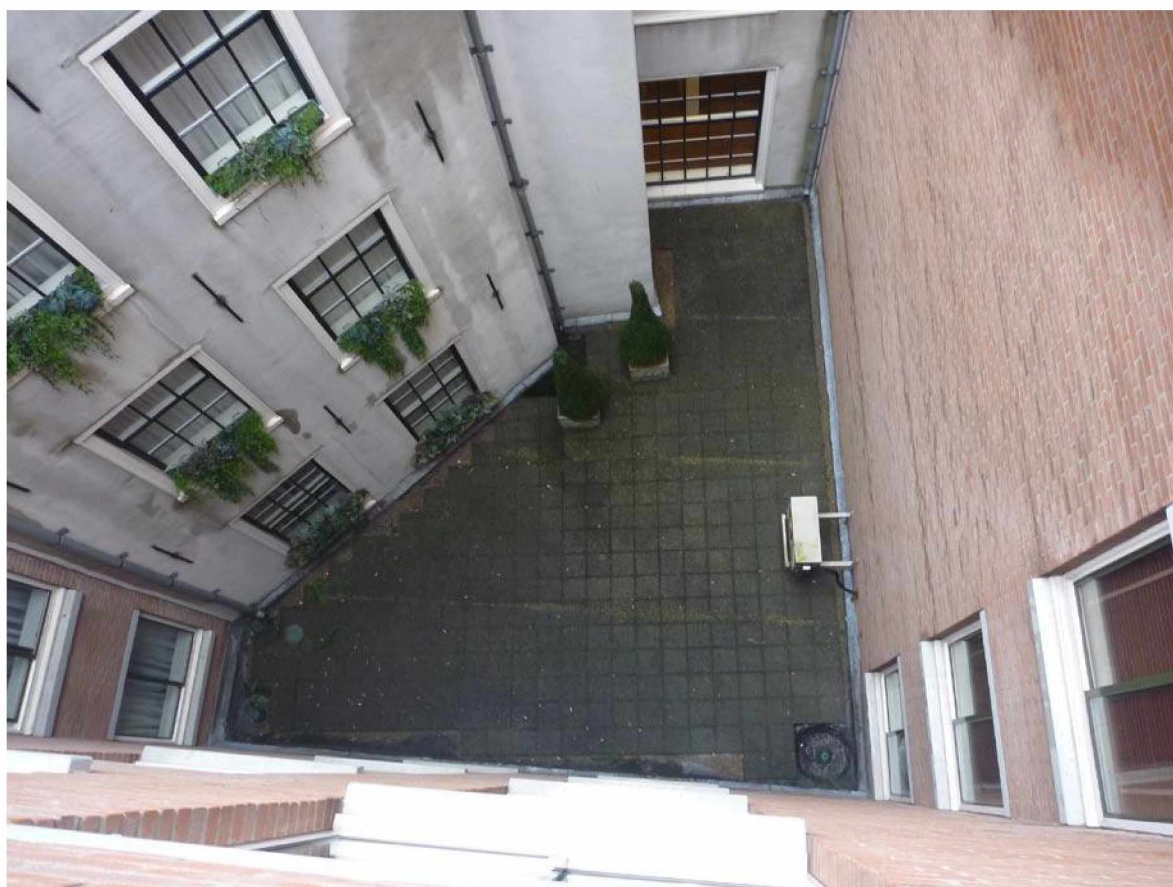
Lichthof 1, dakvloer ligt op niveau 1e verdieping
