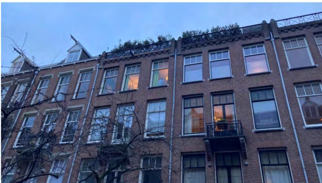
Wouwermanstraat 29-35. Aan beide kanten van het blok bevindt zich al bebouwing met kap.
