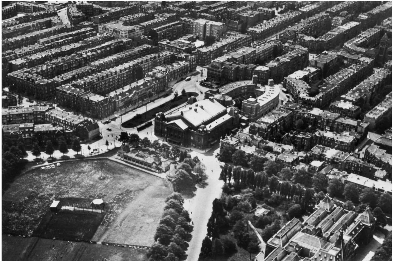
Afbeelding 32: Luchtfoto van het Concertgebouw, genomen in zuidwestelijke richting. Links ervan ligt het J.W. Brouwerplein, op de voorgrond het Museumplein en helemaal rechts voorin ligt het Stedelijk Museum. Te zien is dat, nu de omliggende wijken geheel zijn voltooid, de noordvleugel zich aan het eind van de Alexander Boersstraat bevindt. Uit SAA, BMAB00012000034_014, 1929.
