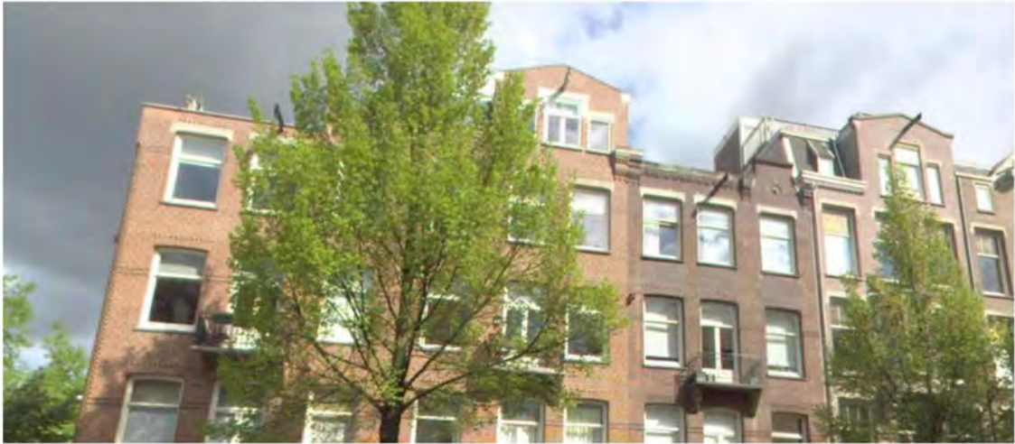
Joh. Verhulststraat 220-224. Nummer 222 is opgehoogd.
