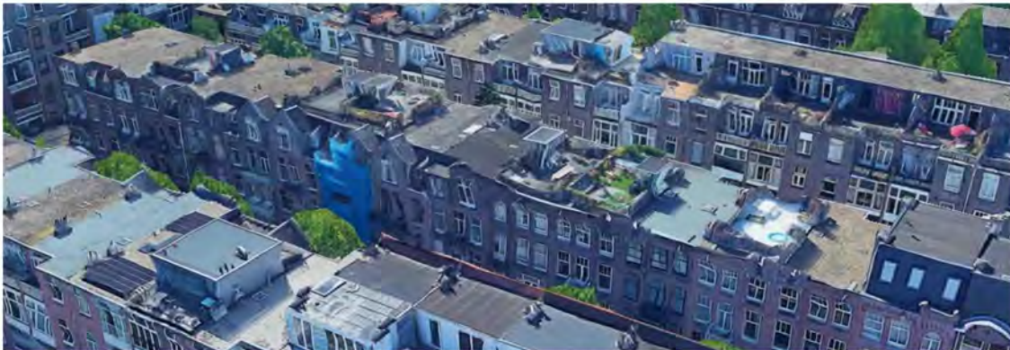
De bebouwing gezien van bovenaf (middelste rij) in zuidoostelijke richting.
