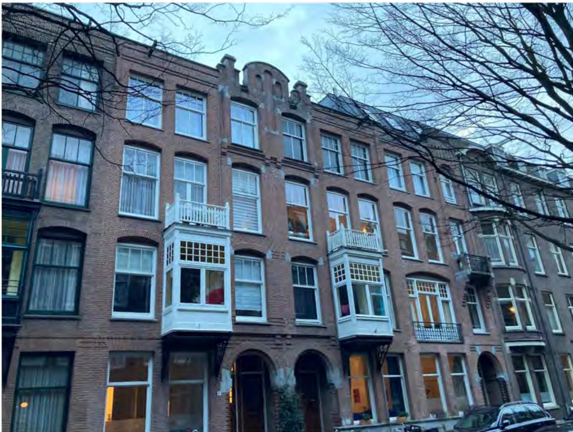
Nicolaas Maesstraat 91-101. Geheel rechts de geplaatste kap op nummer 101. De daken op het blok rechts ernaast zijn van meet af aan onderdeel van het ontwerp.
