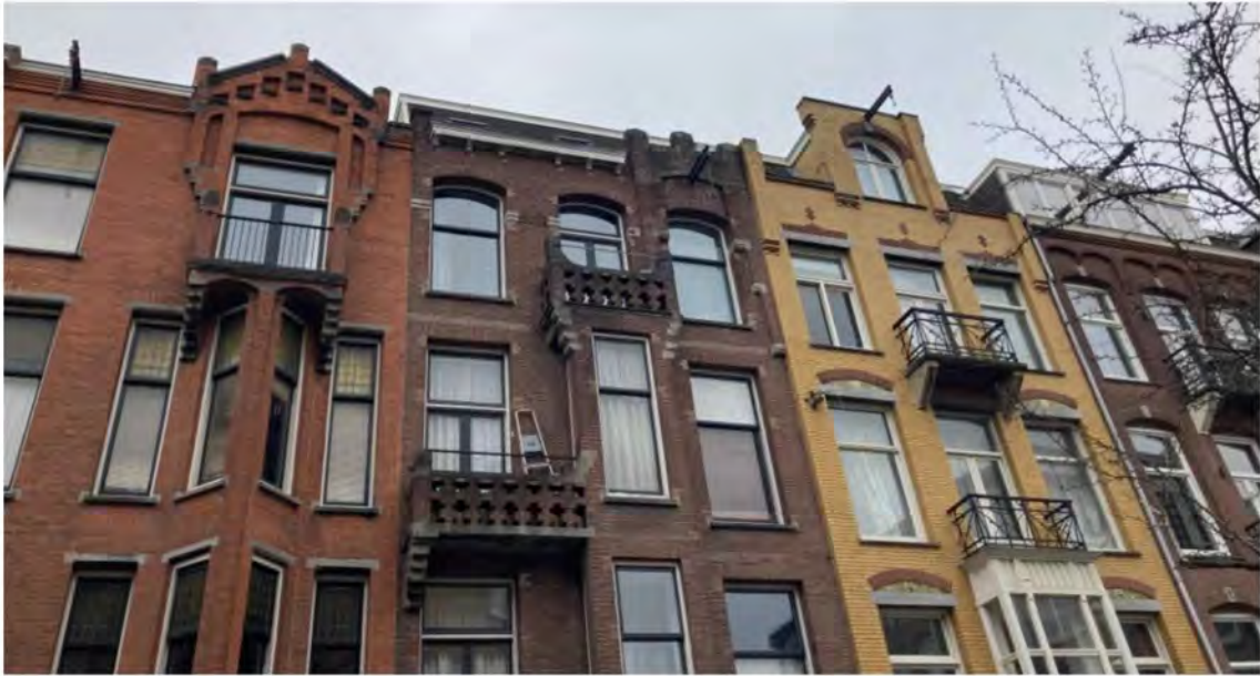
Gevels grenzend aan de Valeriusstraat, in het midden Valeriusstraat 109.
