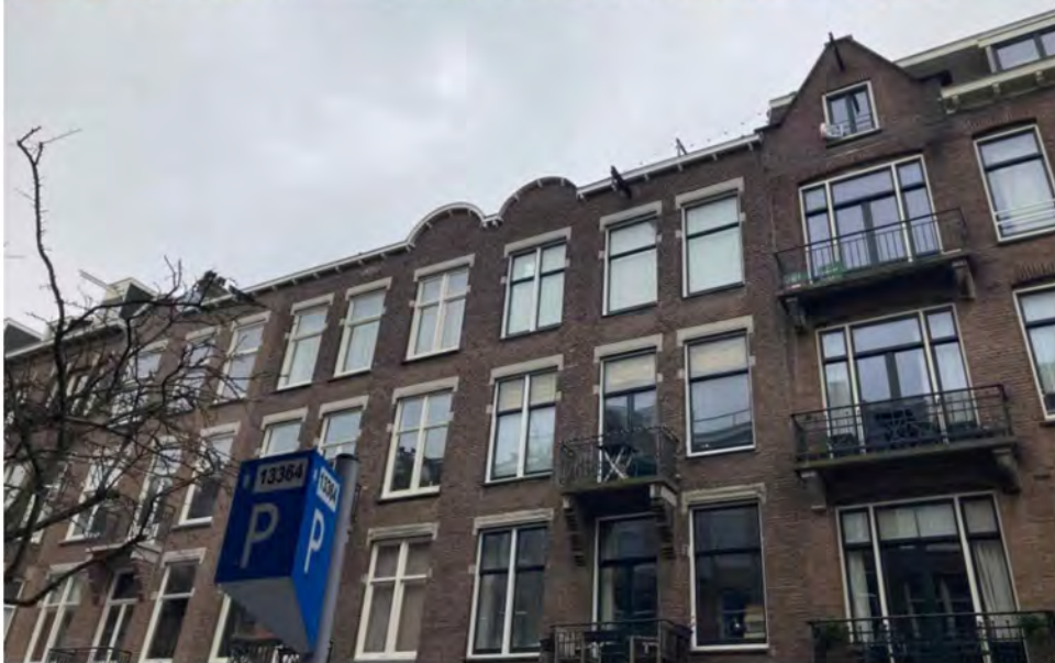
Gevelaanzicht vanaf de straat.
