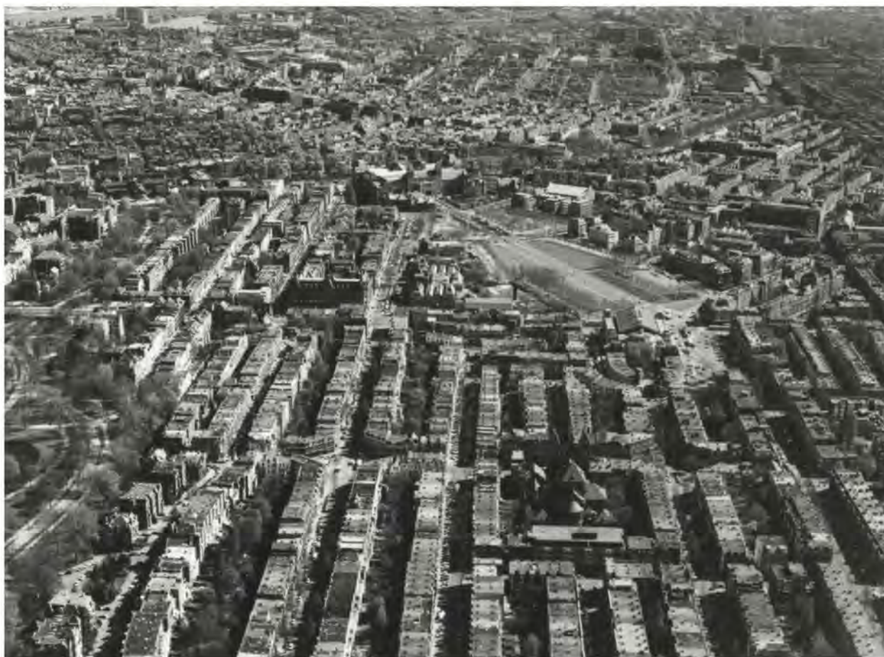
Afbeelding 41: Luchtfoto van het Museumkwartier, gezien in noordoostelijke richting. Op de voorgrond is goed de orthogonale structuur van de Concertgebouwbuurt te zien. Daarachter de waaivormige opzet van de Museumpleinbuurt met Museumplein (nog voorzien van autoweg) en de daaromheen gegroepeerde culturele instellingen en villa's. SAA, B00000037091, 1985.
