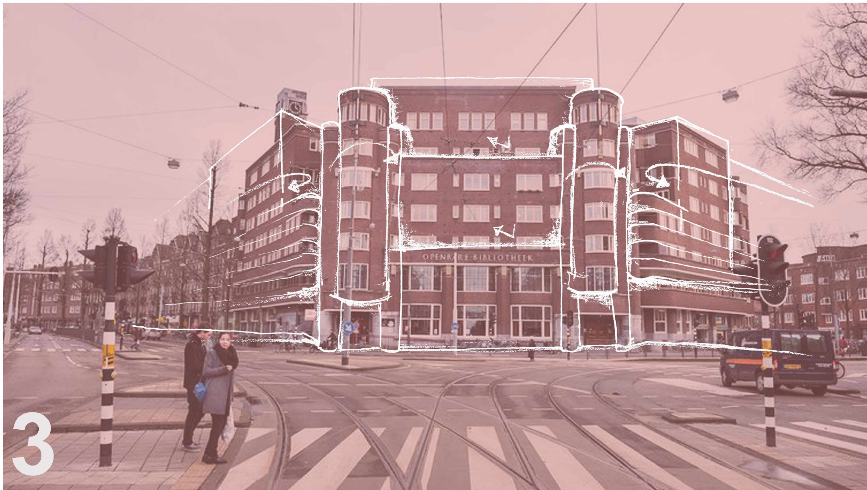
Roelof Hartplein - Het Nieuwe Huis: de afgeschuinde hoek leidt tot een perspectivische verspringing in het stadsbeeld. Er ontstaat een sterke diagonale axialiteit, die hier gemarkeerd wordt door de ronde risalieten.
