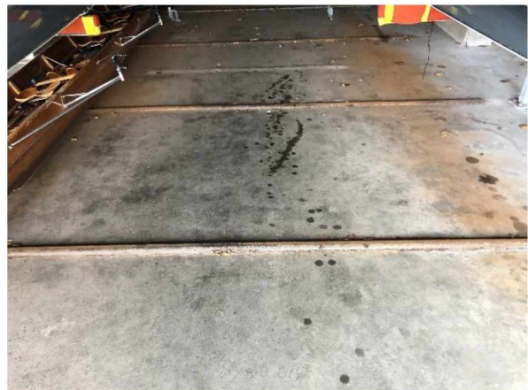
Foto 16: Zware corrosie stalen ligger.
