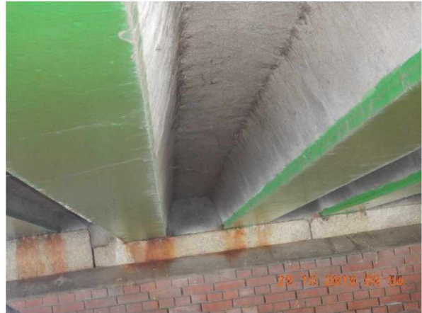
Foto 2: Stalen liggers zonder corrosie.
