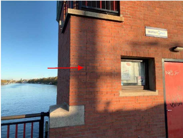
Foto 35: Verticale scheur zuidzijde.
