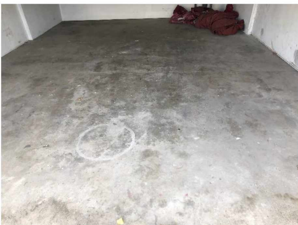
Foto 29: Geen bijzonderheden waargenomen aan de vloeren.
