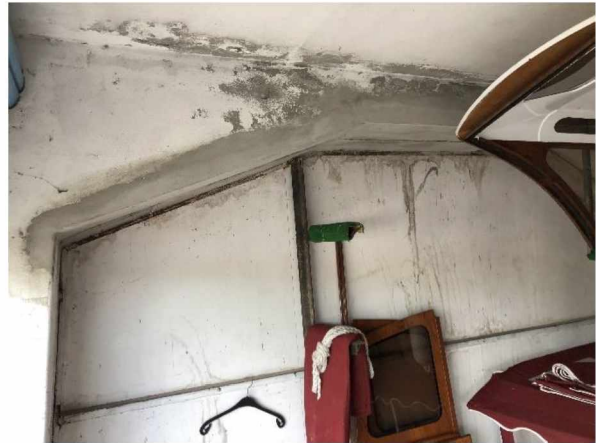
Foto 32: Reparatie onderzijde balk.
