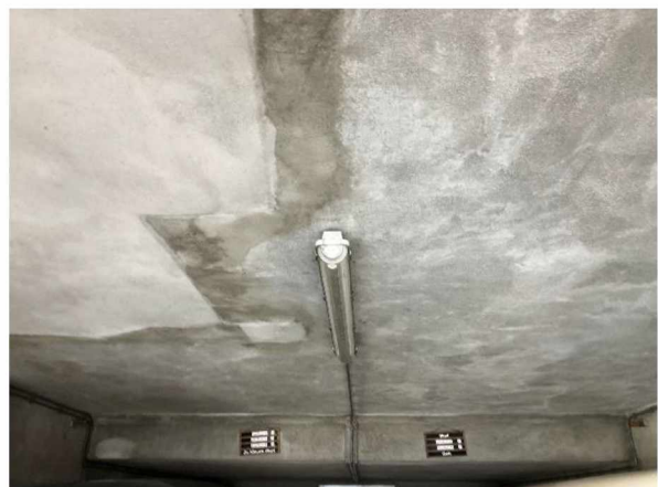
Foto 18: Reparatiedelen in plafond.
