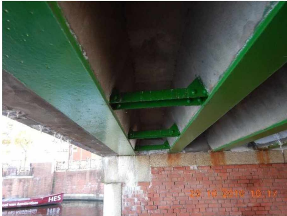
Foto 1: Stalen delen zonder overlaging van beton zijn voorzien van een coating.
