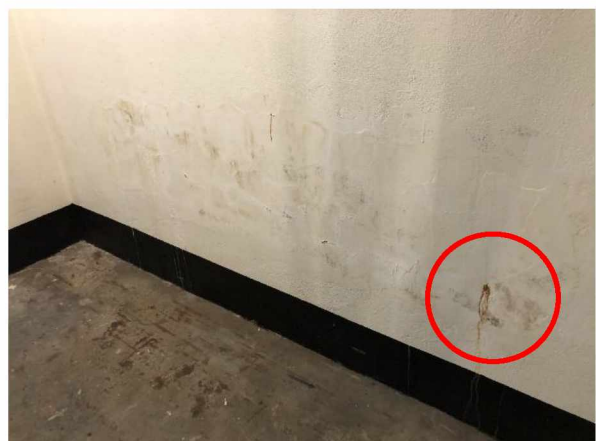
Foto 46: Reparatie in onderzijde wand en bruine uitboeiing (rode cirkel).
