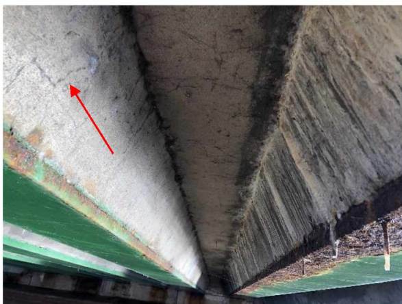
Foto 11: Scheurtjes met een scheurwijdte < 0,1 mm.
