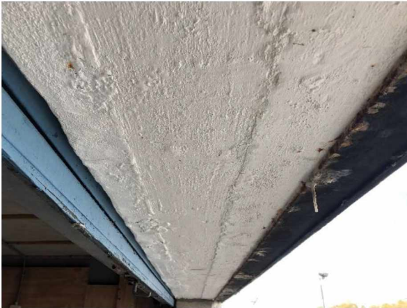
Foto 25: Alleen een coating aangebracht aan het plafond buiten de boxen.
