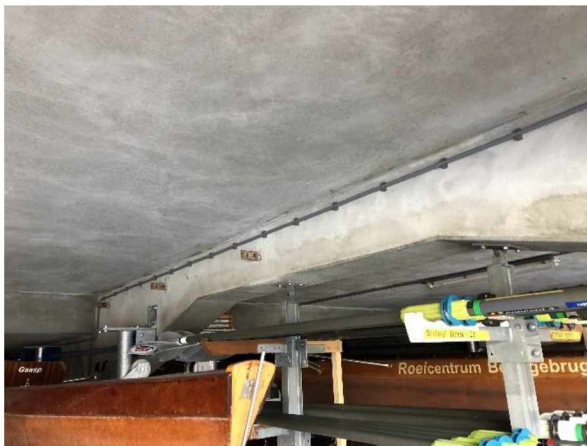
Foto 19: Overzicht plafond en balken voorzien van afwerklaag.
