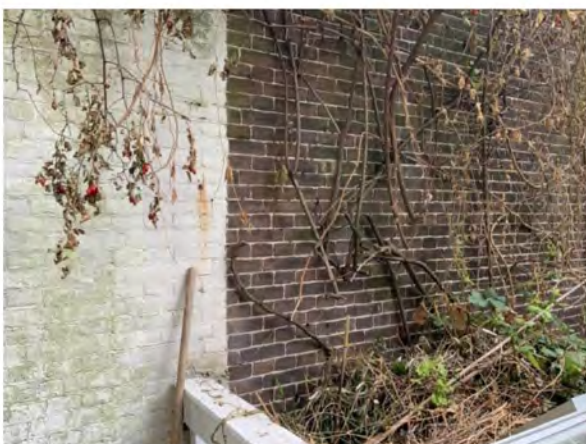
Muren steens gemetseld
