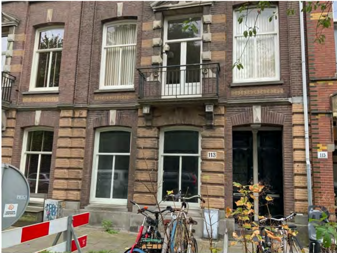
De Woning aan de Eerste Helmersstraat 113 H te Amsterdam
