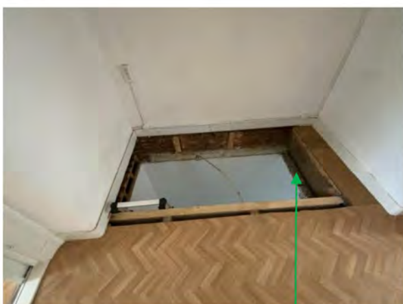
Plafond begane grond is stuc op gaas
