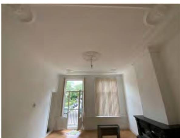
Plafonds 1 e verdieping stuc op riet
