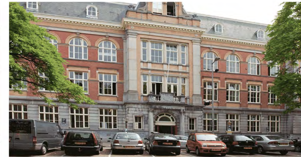
gevel HES gebouw
