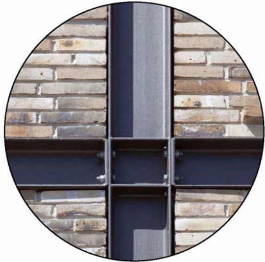
Gevel vakwerk Staal frame
