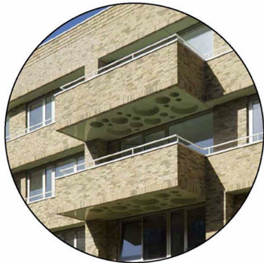
Balkons Metselwerk vloerrand
