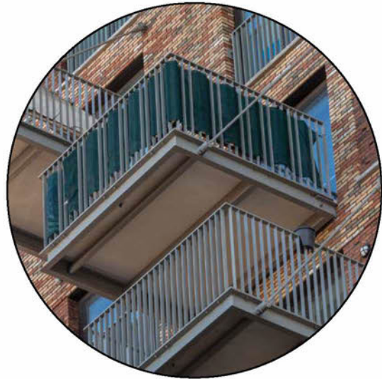
Balkons Stalen afgeschoorde balkons
