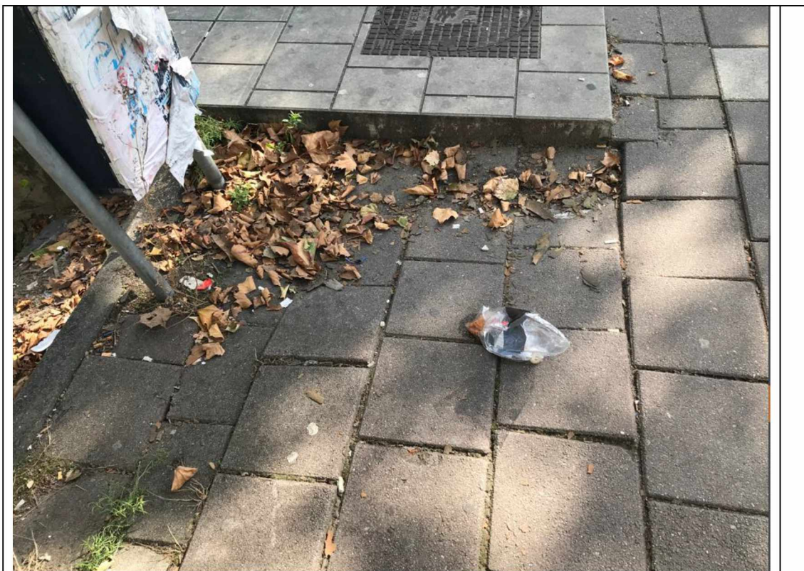
Locatie van aansluiting met rakdeel SIGo804-01 (glooiing) en zetting van het maaiveld
