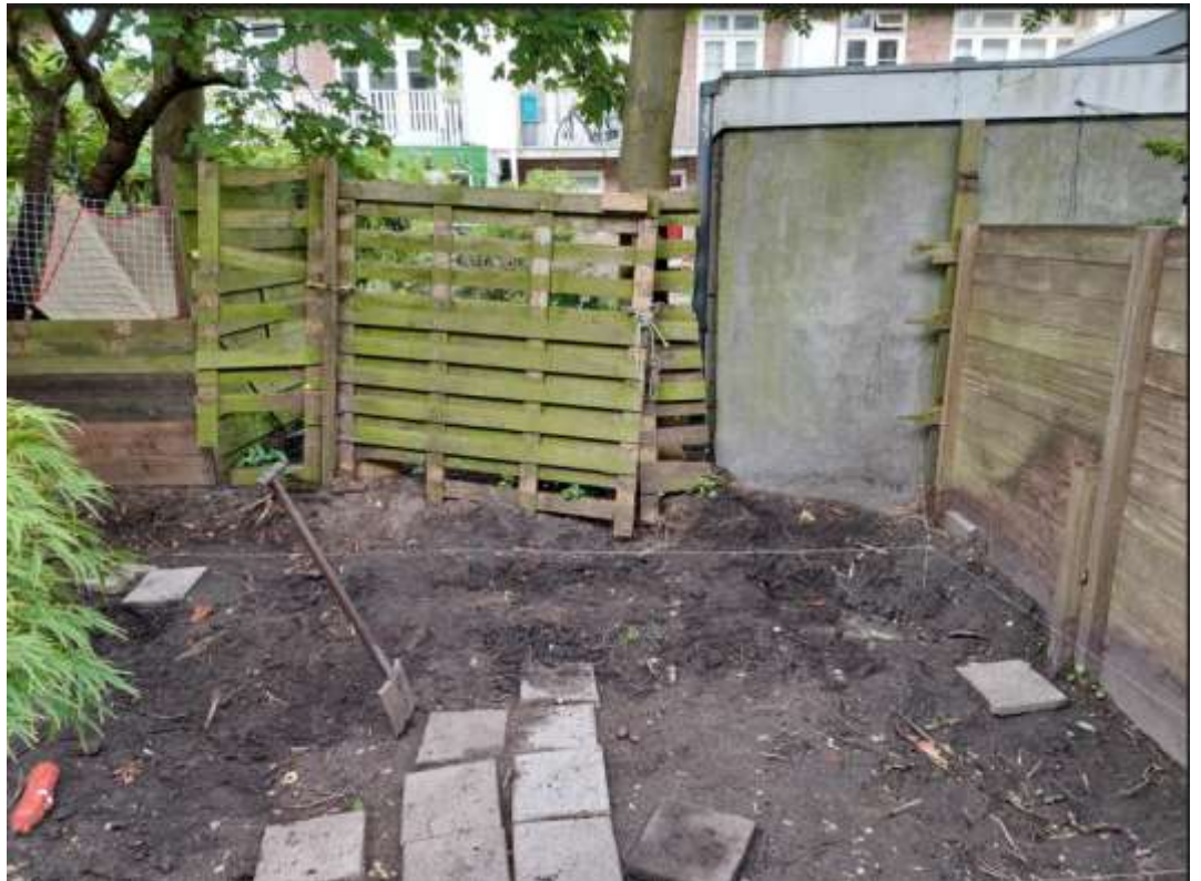
Foto 2. Afgegraven zone met dicht wortelpakket met grote wortels
