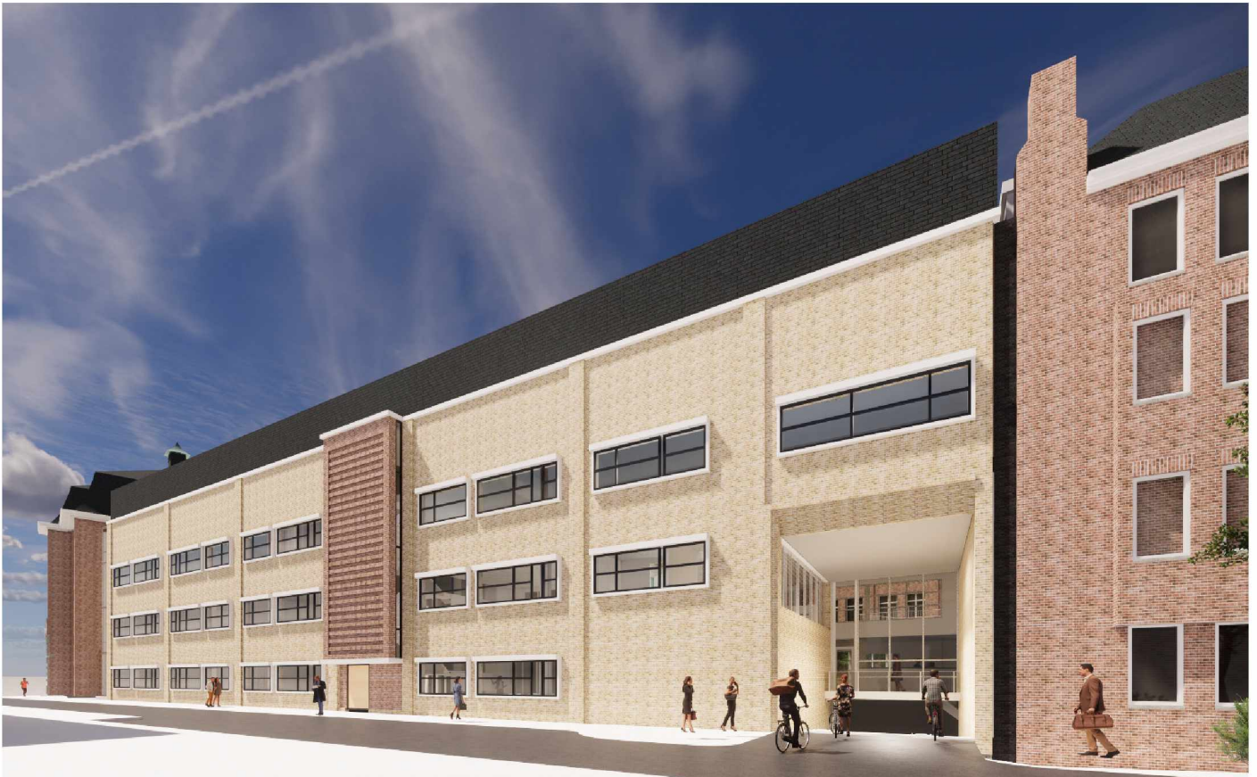
Bouwdeel A vanaf Pieter de Hoochstraat
