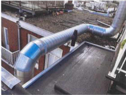
Dak terras 4e verdieping afvoerkanaal versleekt, deels over het dak van Willemsparkweg 218.
