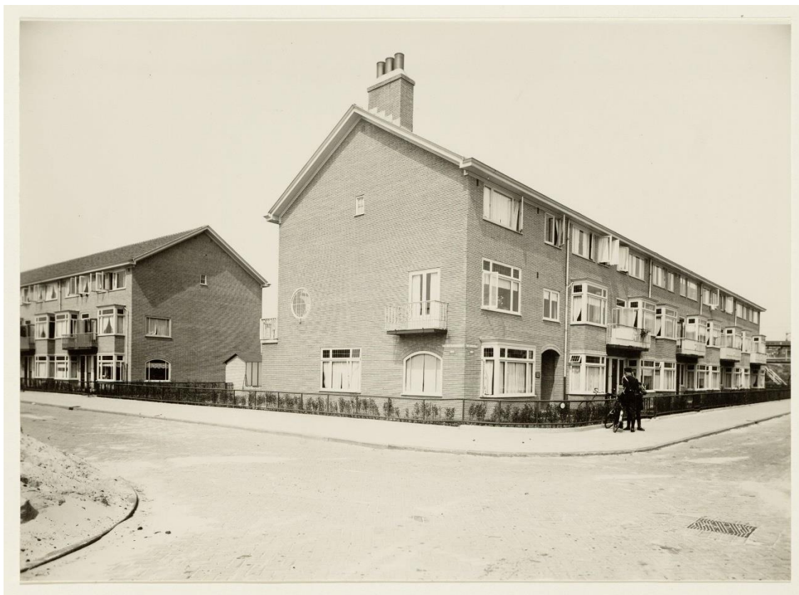
Woningblokken Ter Gouwstraat 2-18 (rechts) en Van der Vijverstraat 2-18 (links), kort na de oplevering. De forse schoorsteen is ten behoeve van de blokverwarming.
