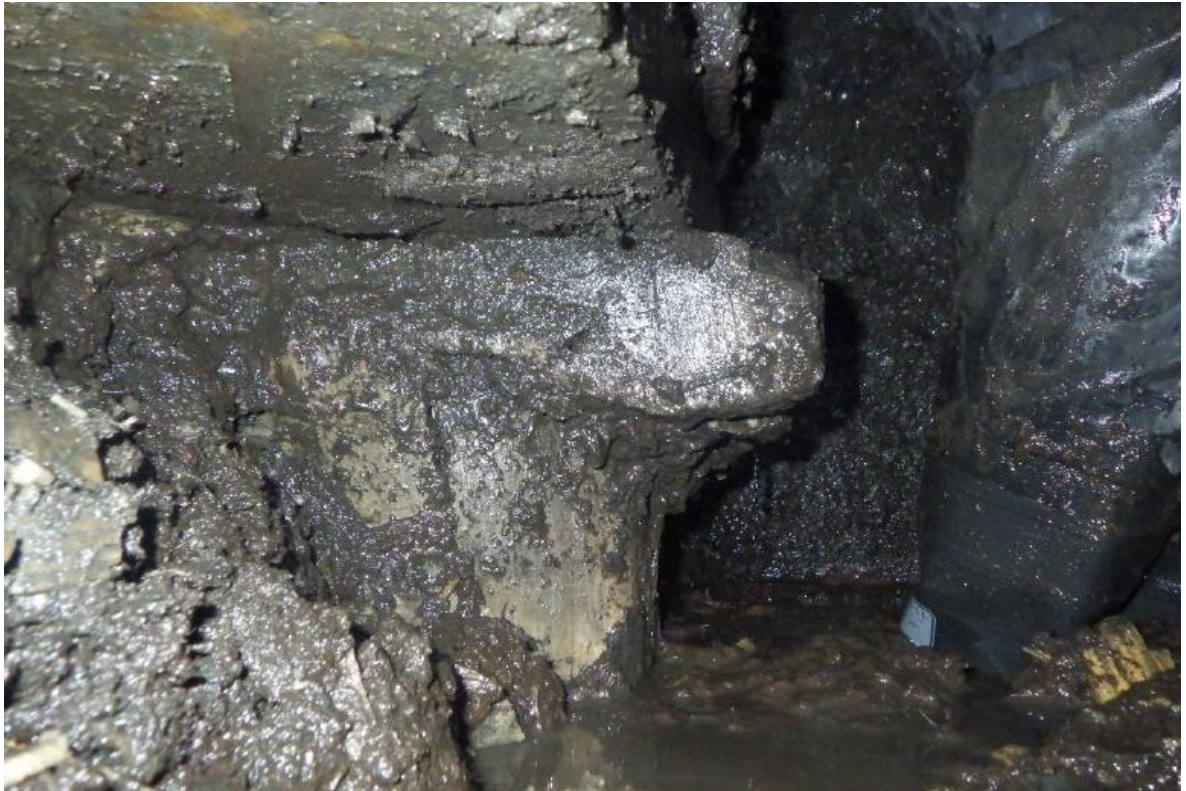
langshout 1, kiesp 2 en paal 2 (kiesp 2 is 50% samengedrukt)
