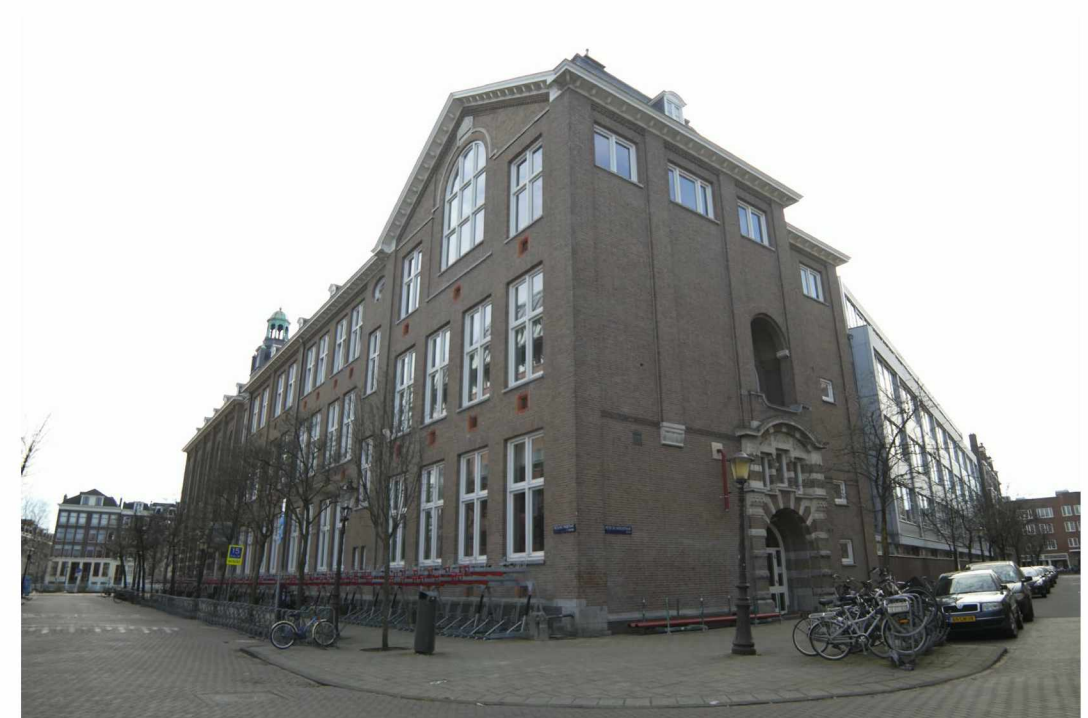
huidige gevel bouwdeel B aan de Nicolaas Maesstraat
