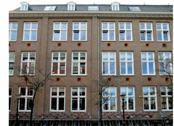
gevelopbouw bouwdeel B met penanten op 7,2 m
