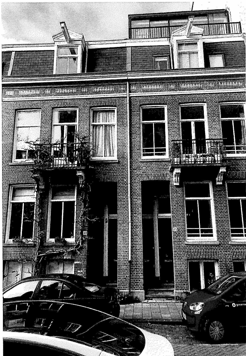
5.1.2.e met dakopbouw 5 e bouwlaag
