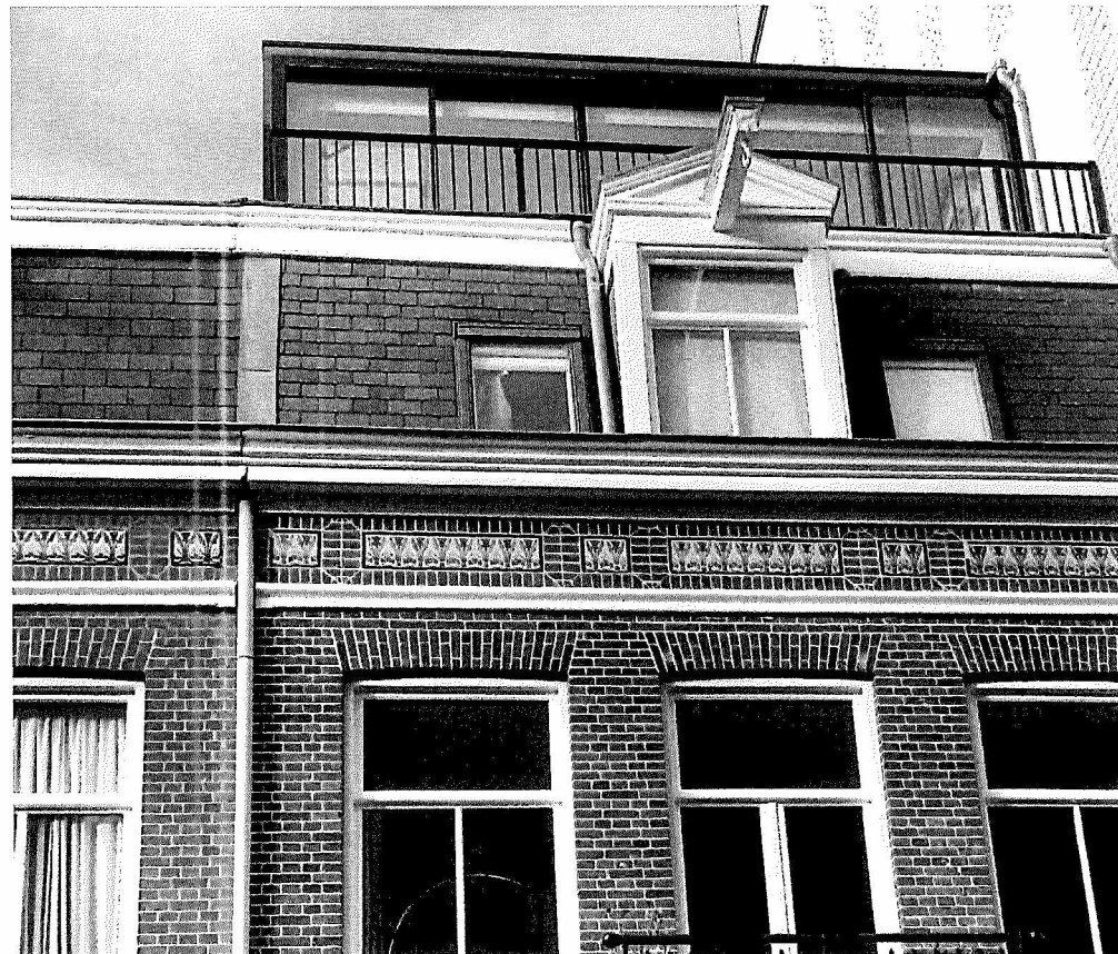
5.1.2.e met dakopbouw 5 e bouwlaag
