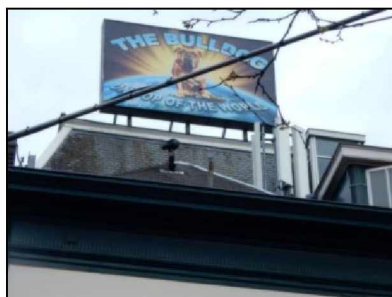
Figuur 7. Detail dak.
