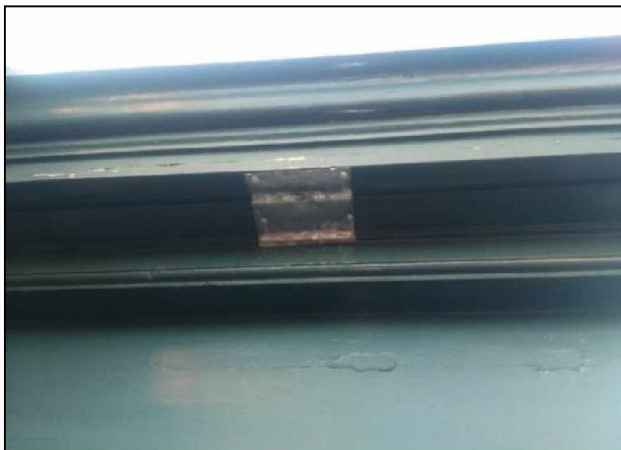
Figuur 12. Afdicht gat met loden strip.
