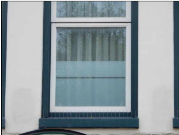
Figuur 13. Vogelwerende pinnen op kozijn.
