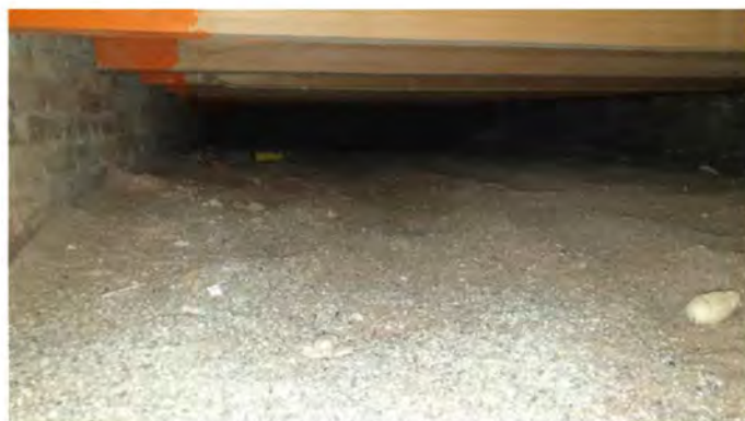
F12 Andreas Bonnstraat 17H Geen asbestverdachte toepassingen in de kruipruimte
