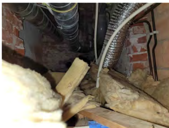
F08 Andreas Bonnstraat 11H Geen asbestverdachte toepassingen boven het verlaagde plafond
