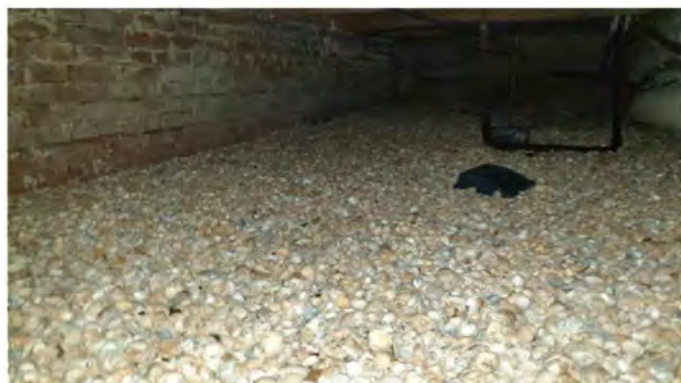
F16 Andreas Bonnstraat 9H Geen asbestverdachte toepassingen in de kruipruimte
