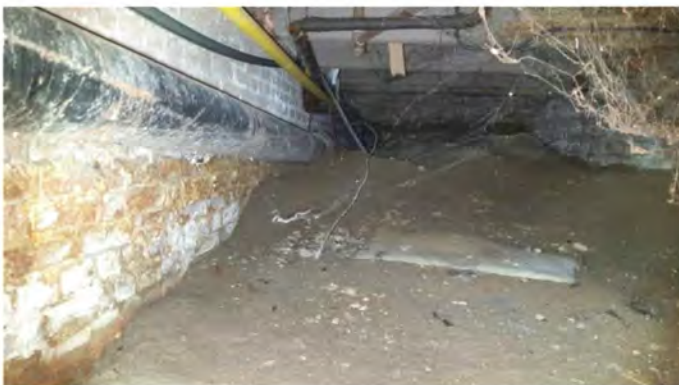
F06 Andreas Bonnstraat 15H Geen asbestverdachte toepassingen in de kruipruimte
