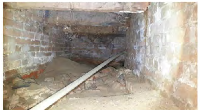
F07 Andreas Bonnstraat 15H Geen asbestverdachte toepassingen in de kruipruimte
