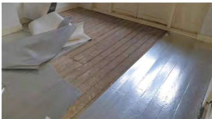
F02 Andreas Bonnstraat 15-1 Geen asbestverdachte toepassingen op de houten vloer
