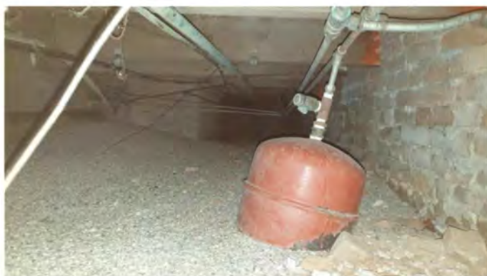
F13 Andreas Bonnstraat 17H Geen asbestverdachte toepassingen in de kruipruimte
