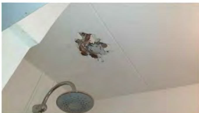
F09 Andreas Bonnstraat 9H Inspectie boven het verlaagd plafond
