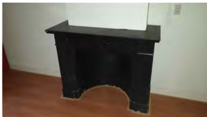
F10 Andreas Bonnstraat 9H Geen asbestverdachte toepassingen ter hoogte van de schouw
