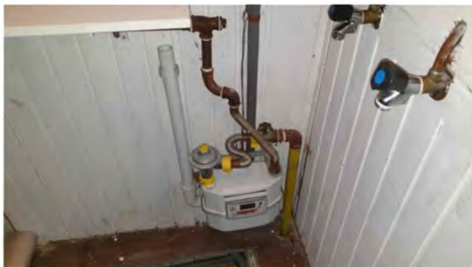
F13 Andreas Bonnstraat 9H Niet asbestverdachte gasmeter
