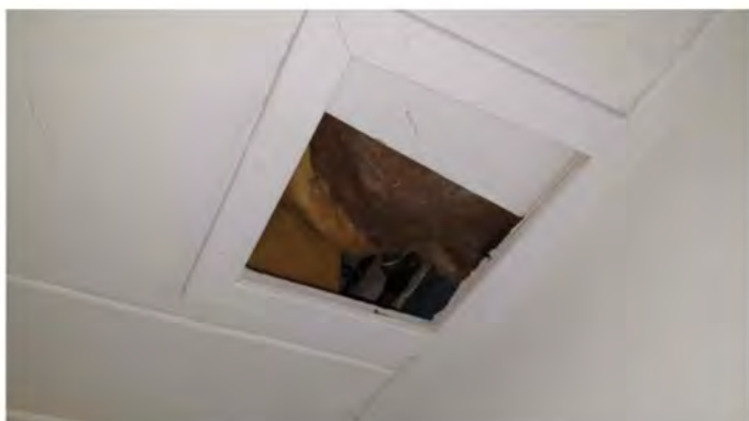
F8 Andreas Bonnstraat 15-3 Inspectie boven het verlaagd plafond
