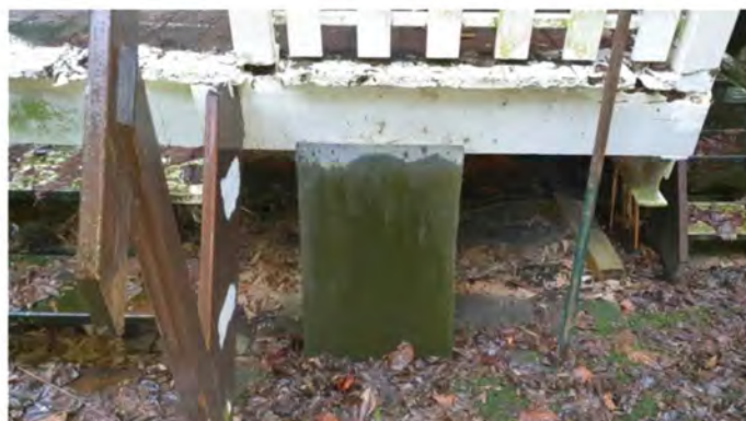
F18 Andreas Bonnstraat 9H Niet asbestverdacht plaatmateriaal in de achtertuin
