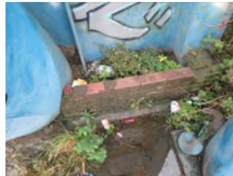
Afgebroken metselwerk
