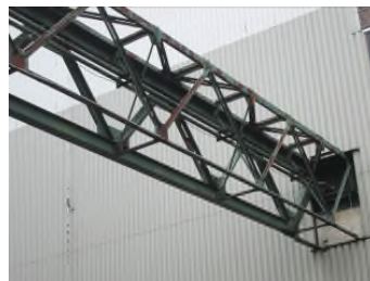
Corrosie overspanningen
