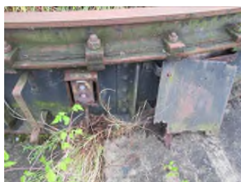
Corrosie staalconstructie
