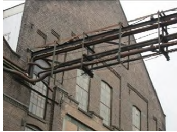
Corrosie staalconstructie
