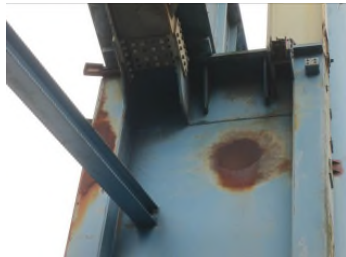
Corrosie staalconstructie
