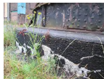
Scheurvorming beton
