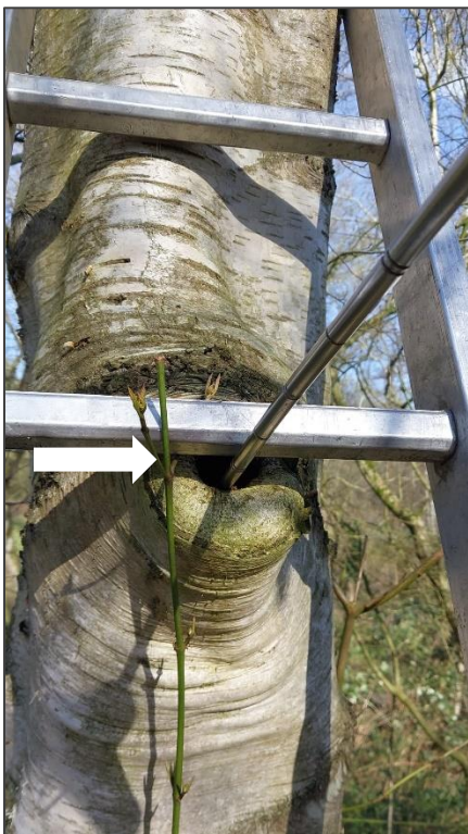
Afbeelding 15. Ondiepe holte zoals te zien door meting met prikstok.
