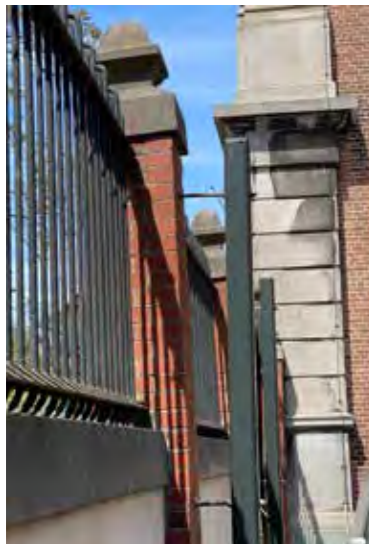
Hulpconstructie: stalen koker 100x100
