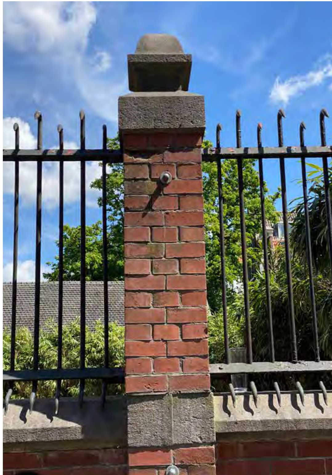
Originele kolom, 16 lagen onderste laag 2x drieklizoor, bovenste laag 3x kop
