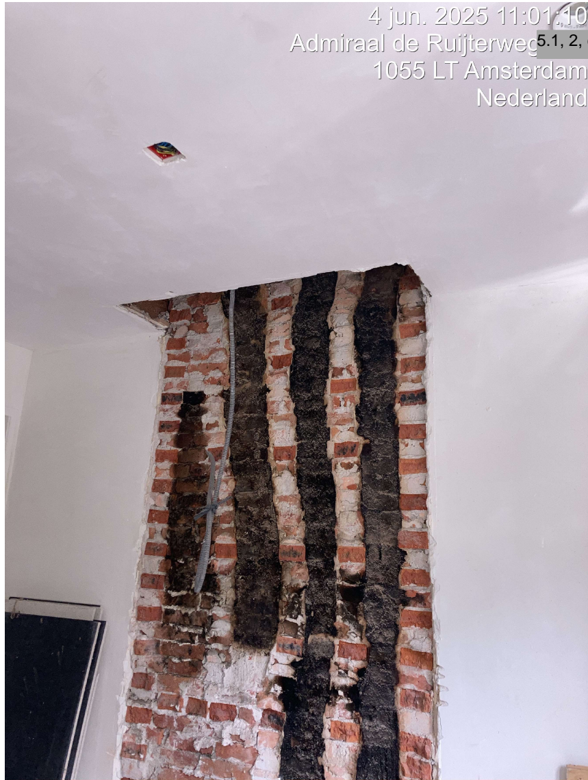
Rookgaskanaal vanuit keuken op bovenliggende verdiepingen volledig verwijderd.
