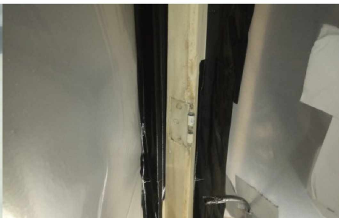
toelichting foto: wanden gedeeltelijk afgeplakt met folie/tape - locatie gesaneerde toepassing
