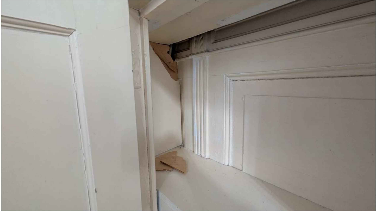
Binnenkant onderkasten, zichtbaar het oorspronkelijke paneel tegen de bouwmuur. Kastenwand is gebouwd met gedemonteerde onderdelen tegenoverliggende kast.
