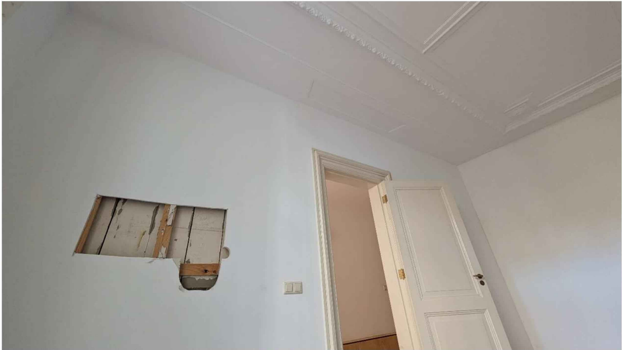
Kamer -1.04, in plafond en achter voorzetwanden is te herleiden dat hier oorspronkelijk ook een kast hoort te staan, vermoedelijk is deze gedemonteerd en gebruikt om de huidige kastenwand te bouwen.
