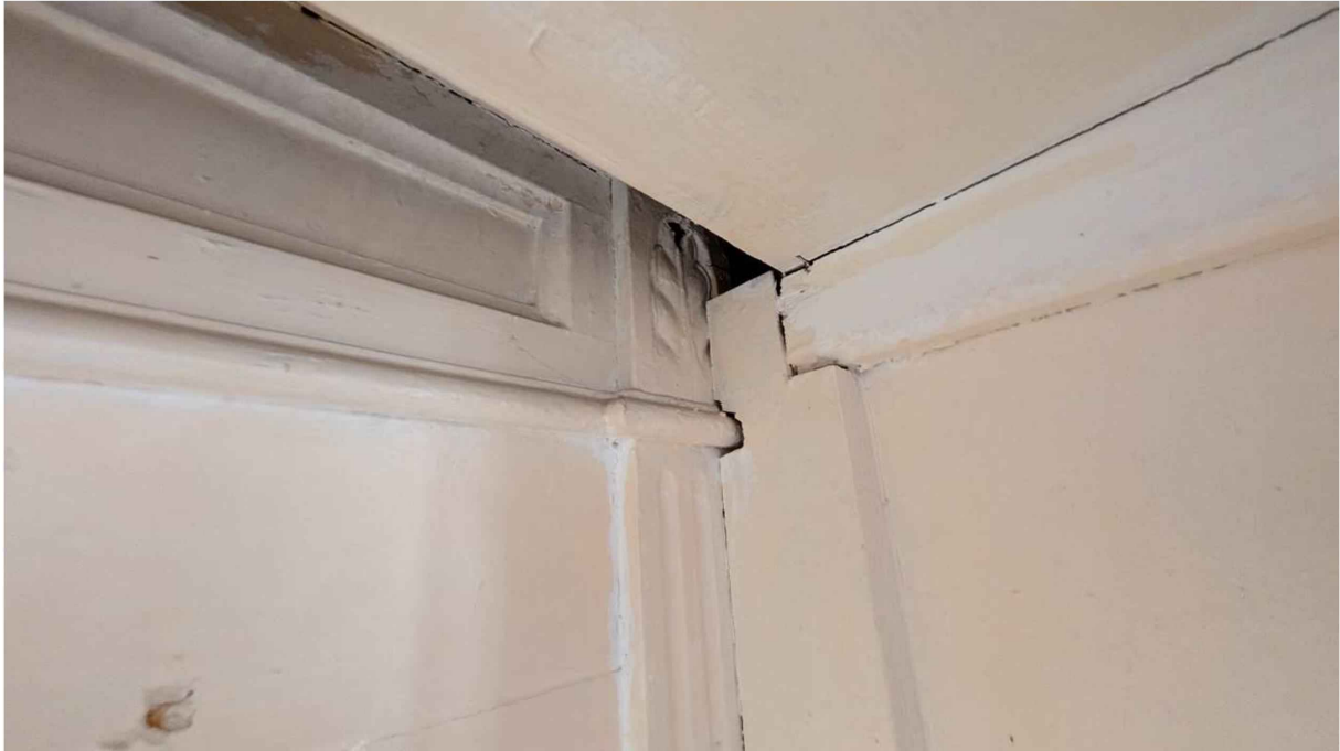
Binnenkant onderkasten, zichtbaar het oorspronkelijke paneel tegen de bouwmuur. Kastenwand is gebouwd met gedemonteerde onderdelen tegenoverliggende kast.
